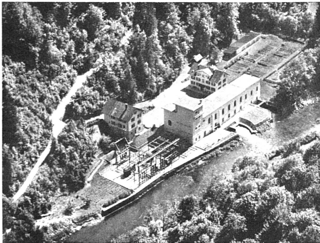
USINE DE LA GOULE SUR LE DOUBS
