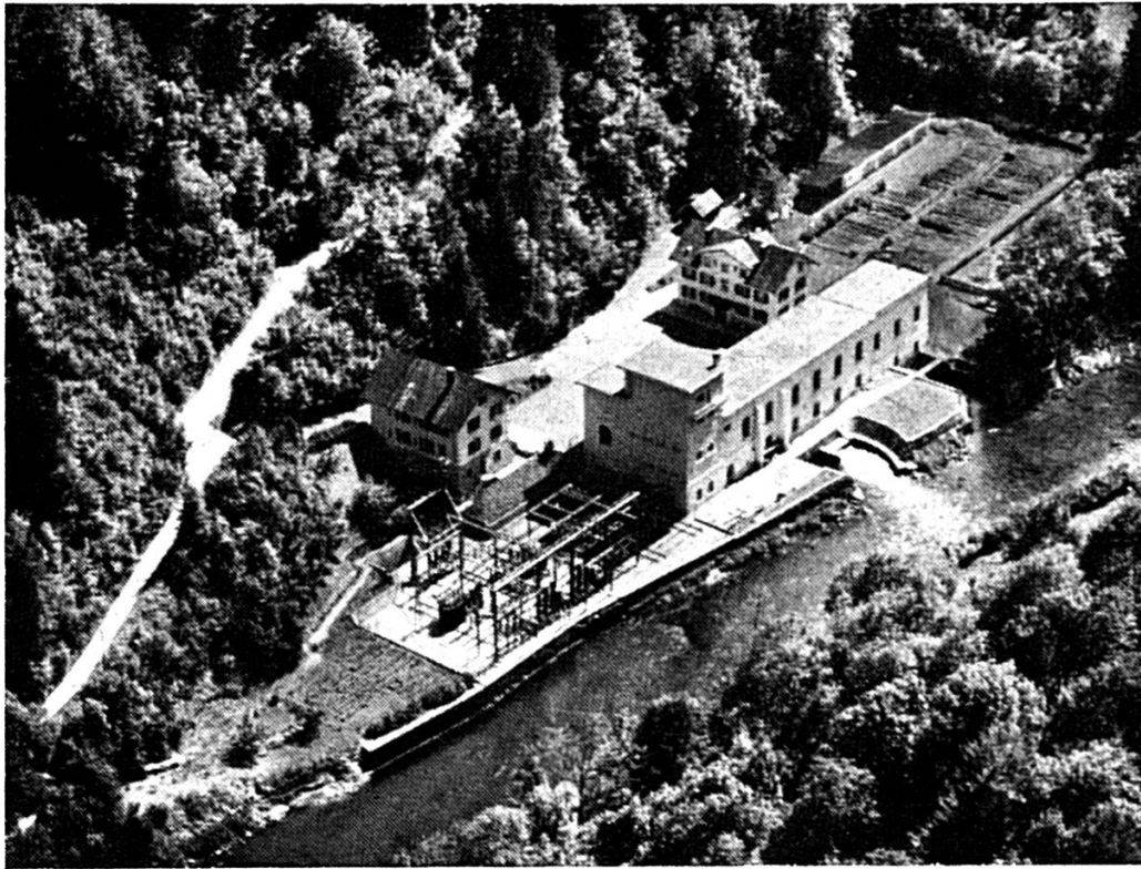
USINE DE LA GOULE SUR LE DOUBS
