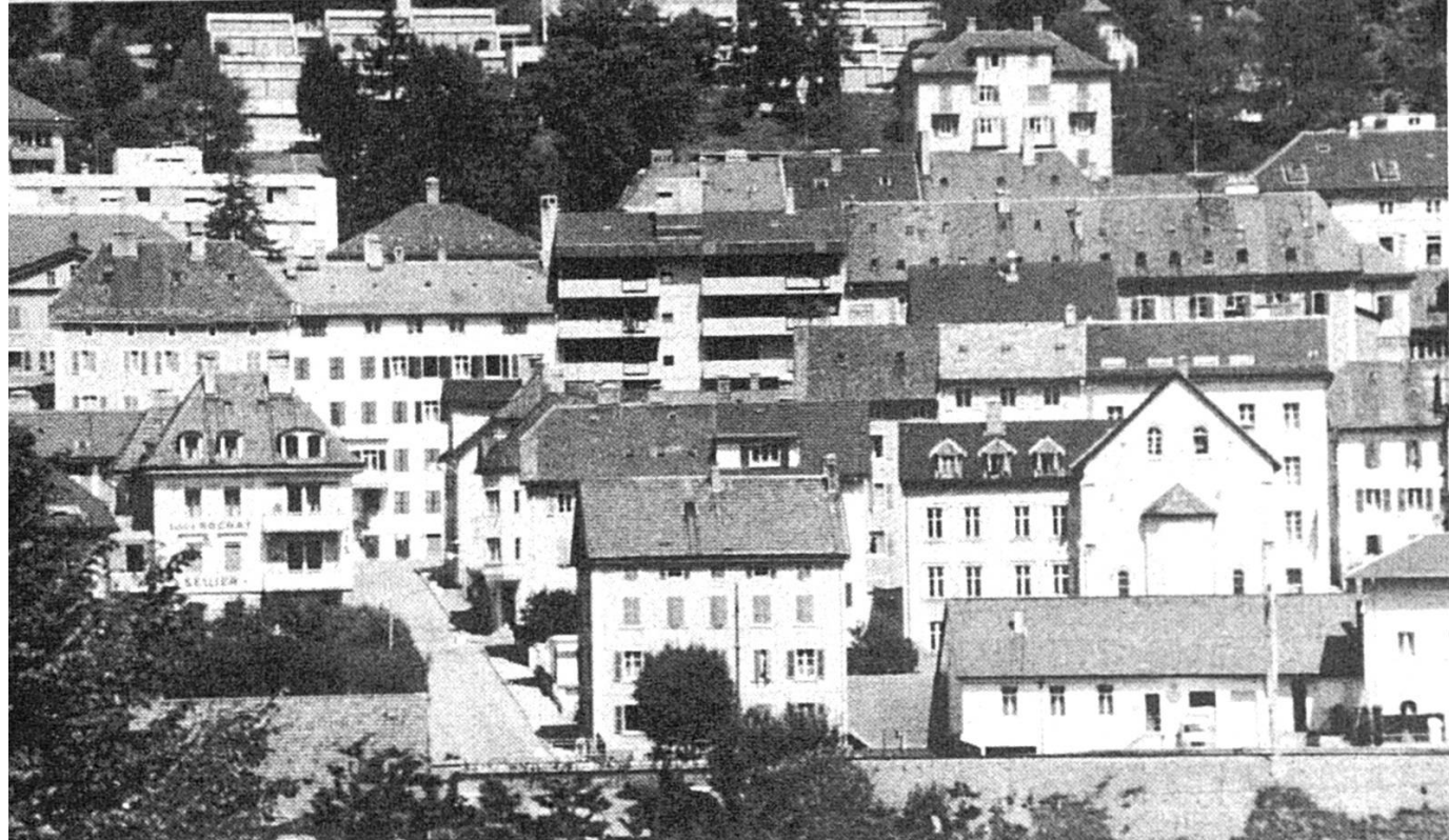
◀ ⑩ Saint-Imier, vue générale (photo aérienne Swissair) ▲ ⑪ Saint-Imier, détail (photo F. Schaer)
