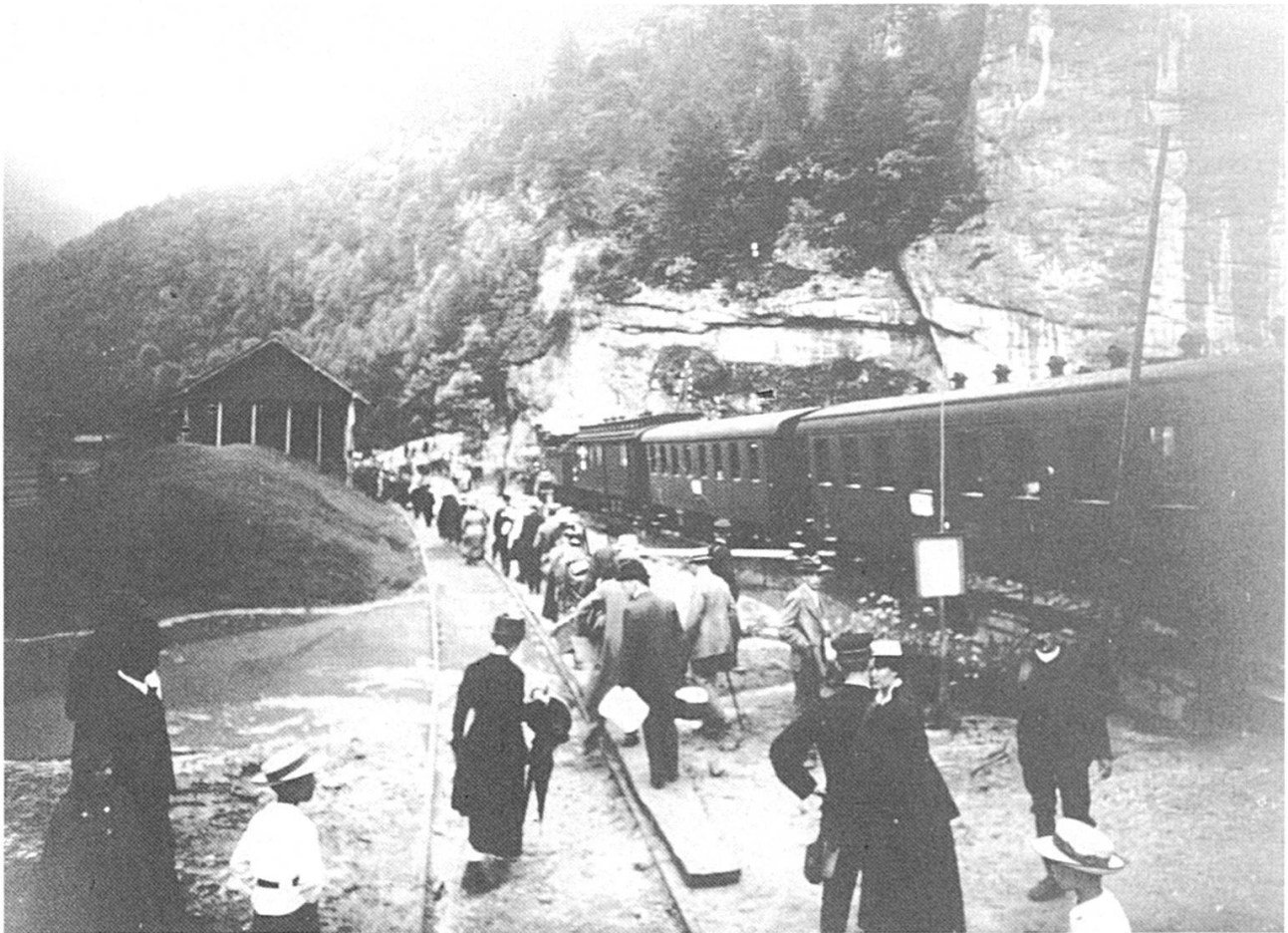
Transbordement des voyageurs à la suite de l'arrêt de l'express Bienne-Delémont, suite à un éboulement en amont de la gare de Choindez, le 29 janvier 1928. Un ancien ouvrier avait le souvenir d'un arrêt forcé du Paris-Milan : transbordement des valises par les gosses, qui récoltaient ainsi quelques pourboires et qui voyaient pour la première fois des "nègres".
