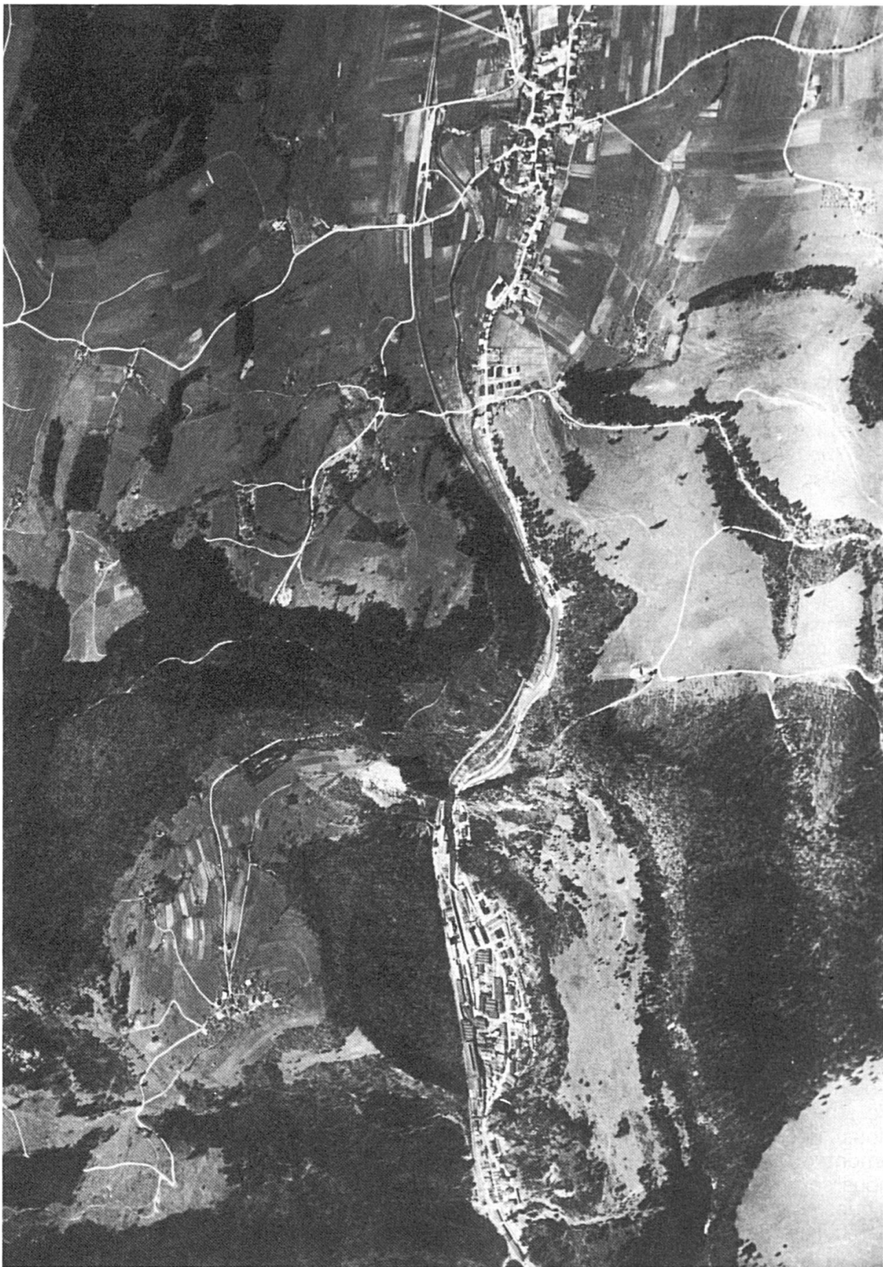
Choindez vers 1922, vue aérienne (Swissair/Photo+Vermessung AG).
