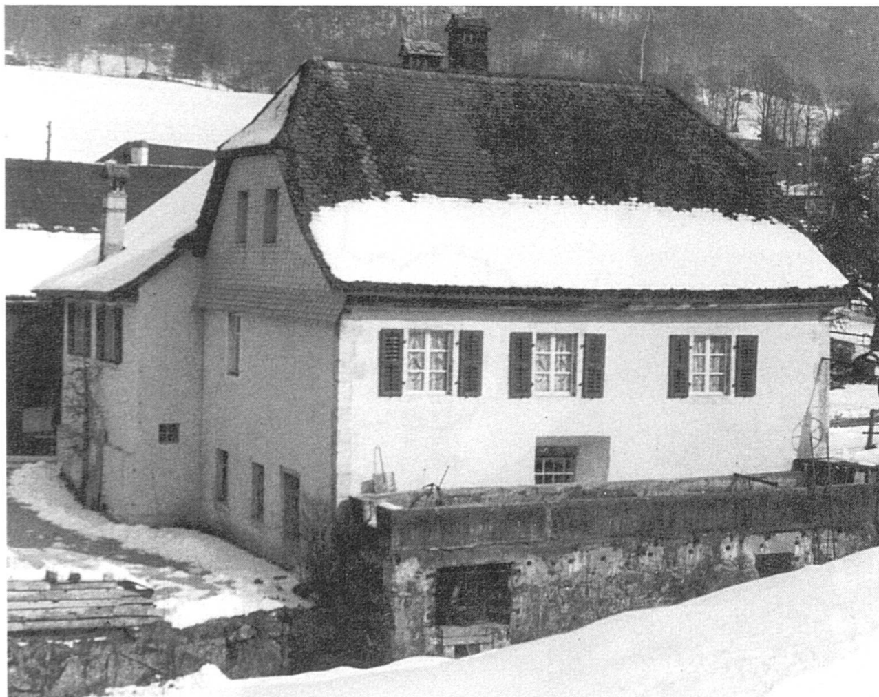
Le bâtiment rénové abritant le Martinet de Corcelles.
