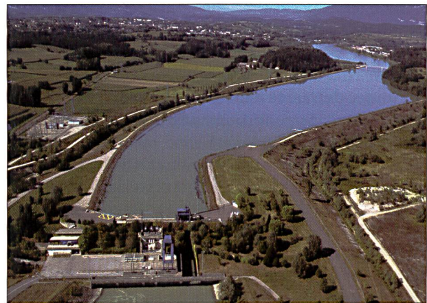
Fig. 1: Usine barrage de Belley (Am) (crédit photo: Nicolas Rigard/CNR).
