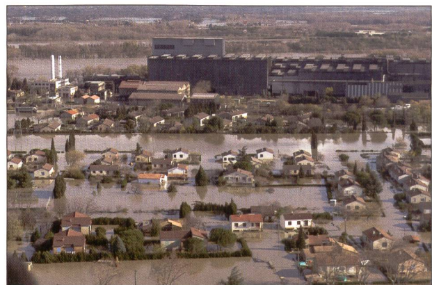
Fig. 3: Inondations en décembre 2003 (crédit photo: Conseil général du Gard).
