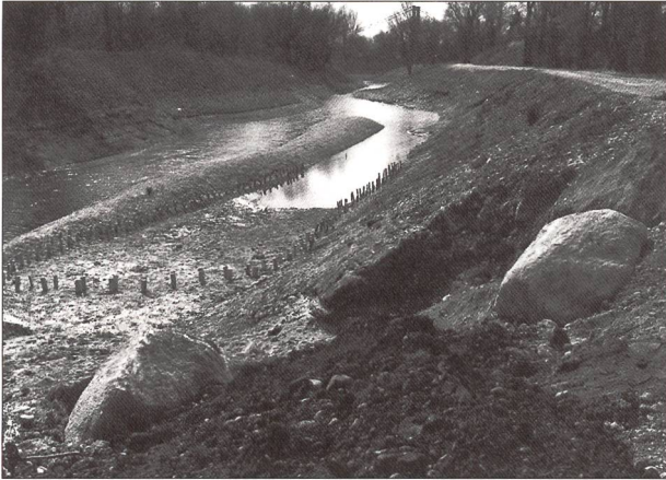
Fig. 5: Programme de restauration des lînes sur l'île de la Table Ronde, en aval de Lyon (crédit photo: N. Hugues/MDFR).
