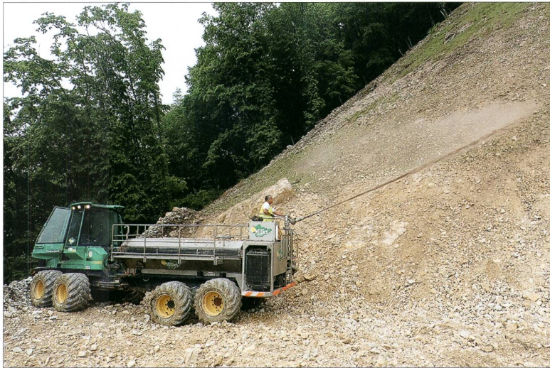
Fig. 2. Projection hydraulique du mélange grainier constitué à l'aide d'une lance à eau (04.05.2015).
