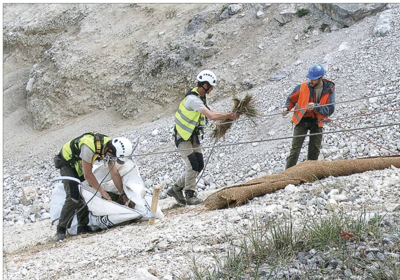
Fig. 1. Paillage d'inflorescences de stipes calamagrostides sous un géotextile fixé (30.04.2015).
