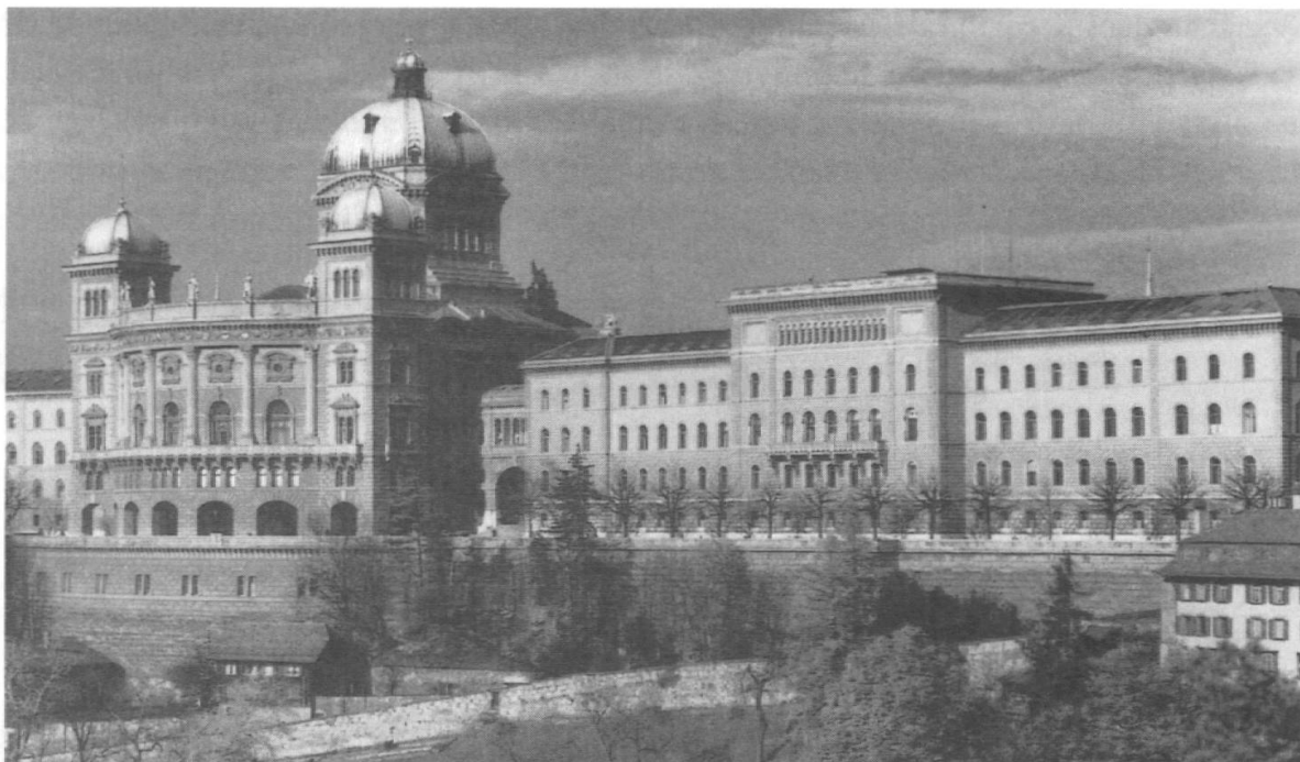
Le Palais fédéral vu du sud. Quarante ans après le style épuré des deux ailes (on voit ici l'aile ouest, à droite, reprenant symétriquement la carrure de l'aile est), le corps central illustre l'évolution de l'architecture administrative fédérale. La fabrique Cailler, elle, n'ira pas jusqu'au baroque, mais il s'en est fallu, hélas, de peu! MEYER André, L'architecture profane. Ars Helvetica IV. Pro Helvetia/Editions Desertina 1989, p. 214.
