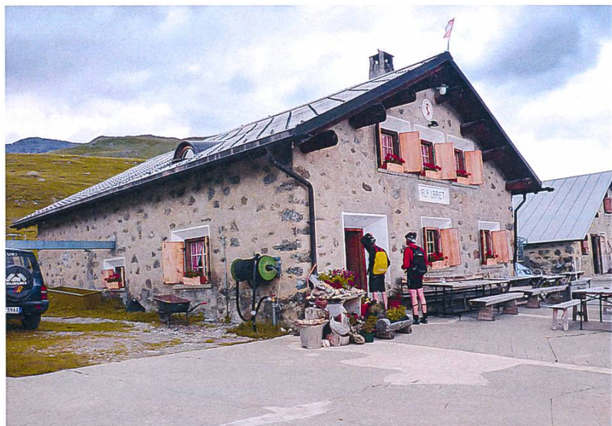
Abb. 11: Sennhütte der Alp Laret, 1938 nach Plänen des Kantonalen Meliorationsamtes errichtet. Heute mit agrotouristischer Nebennutzung (Foto B. Furrer 2011).
