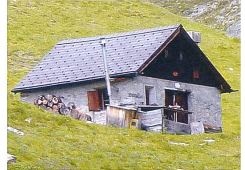
Abb. 1: Hirtenhütte der Alp Tasna/Ardez. Bruchsteinmauerwerk mit Eterniteindeckung (Foto: B. Furrer 2011).
