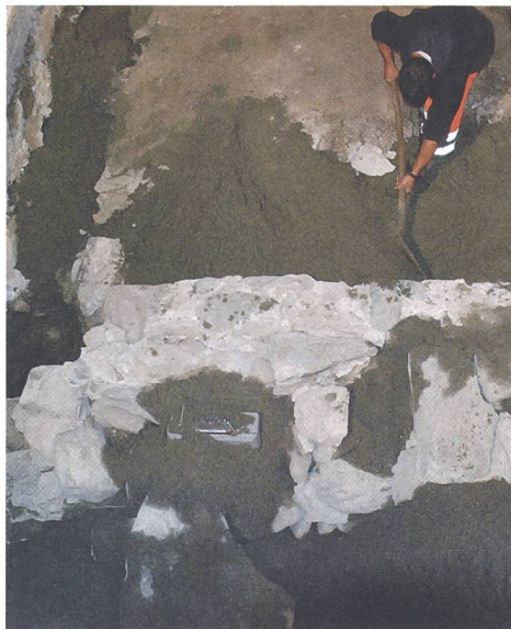
Abb. 5: Tamins, evangelisch-reformierte Kirche. Renovation 2010/11. Nach Abschluss der archäologischen Untersuchungen werden die Sondiergräben mit den freigelegten Mauern der Vorgängerkirchen zur Sicherung mit Sand eingedeckt. Blick gegen Osten.
