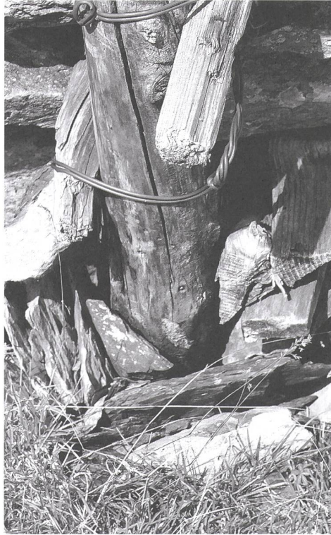
Abb. 24: Alp Pescegallo Foppe, calécc c1048. Der Holzpfeiler, pasùn , wurde mithilfe von Keilsteinen im Boden verankert. Aufnahme 28.7.2011.
