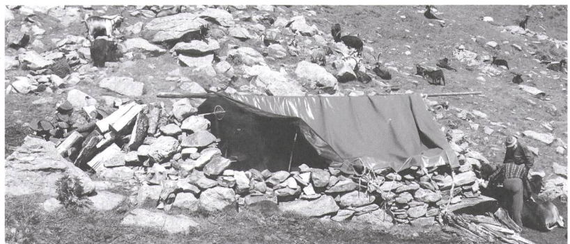
Abb. 12: Gemeinde Gerola Alta, Valle della Pietra, Alp Trona Soliva, calécc del stràch , c1017. Seitenansicht, Typus 3 , das heisst, die Firstpfette wird auf die beiden Erhebungen, matòch , gelegt. Aufnahme 2.8.2011.
