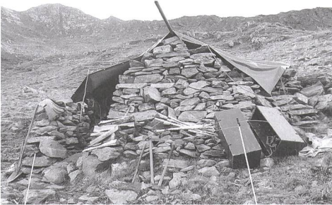
Abb. 110: Alp Trona Soliva. Seitenansicht des calécc del valèt , c1020. Die Vordermauer war über den Winter teilweise in sich zusammengefallen und musste vor Bezug des calécc in Stand gesetzt werden. Aufnahme 16.8.2012.
