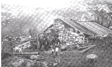
Abb. 125: Alp Montagne de Charouge à Saint-Bon, Gemeinde Bozel, Tarentaise. Die Bauten mit temporärem organischem Dach werden hier als camps-volants bezeichnet. Die Aufnahme wurde 1907 publiziert
