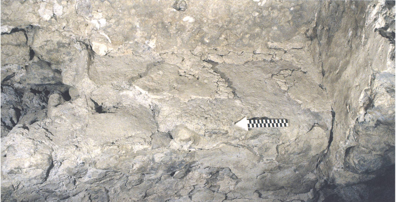
Abb. 107: Tomils, Sogn Murezi. Verputzreste auf der südlichen Sitzbankfläche. Blick nach Osten.
