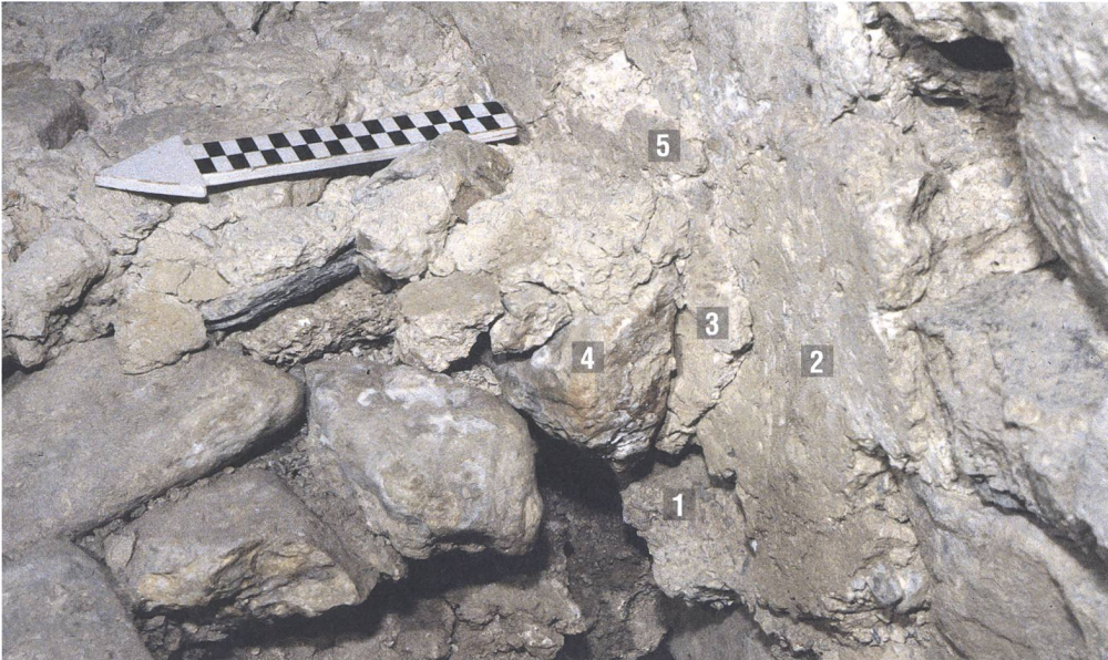
Abb. 114: Tomils, Sogn Murezi. 1 Mörtelboden (118), 2 Wandverputz (971) der ersten Kirche, 3 verstrichener Mauermörtel des karolingerzeitlichen Apsis-schenkels (964), 4 karolingerzeitlicher Boden (981), 5 karolingerzeitlicher Veputz. Blick nach Südosten.
