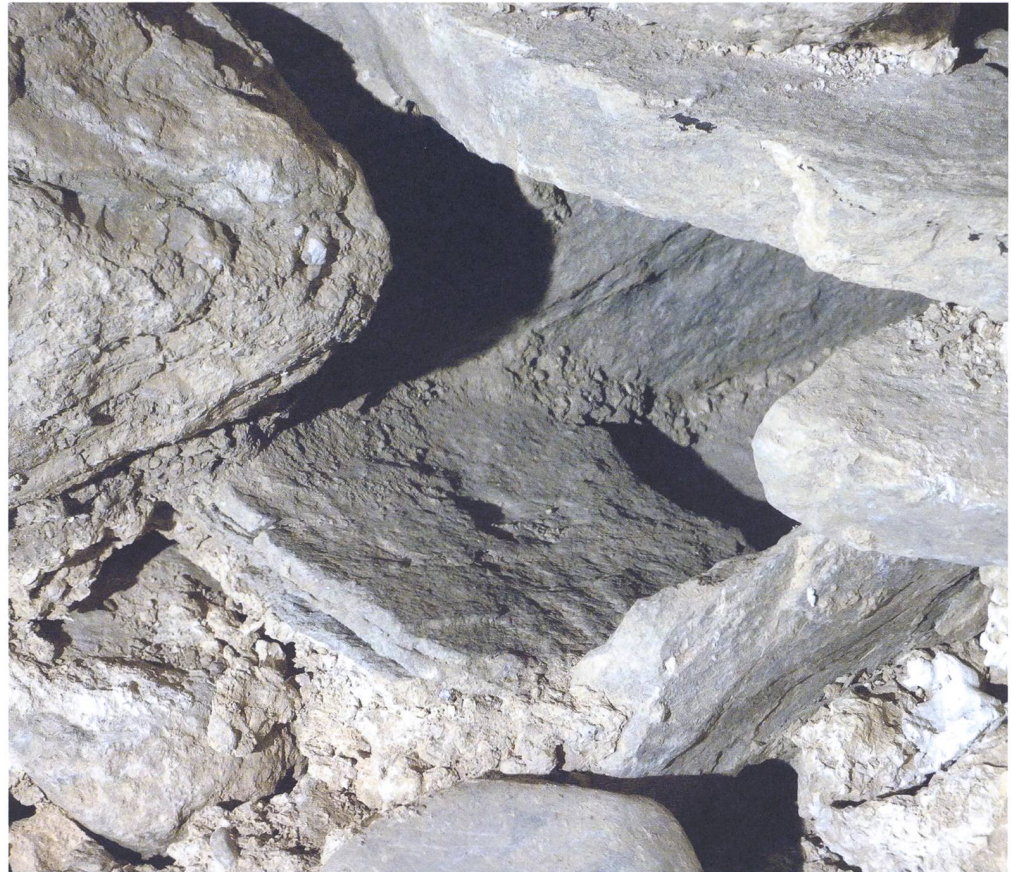
Abb. 82: Tomils, Sogn Murezi. Die Öffnung des Ausguss- kanals (1021) gegen das Kircheninnere liegt knapp über dem Boden. Blick nach Südwesten.
