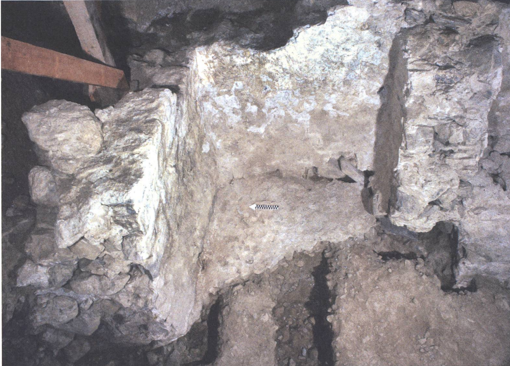
Abb. 76: Tomils, Sogn Murezi. Nördlicher Seitenraum des Altarraumes. Blick nach Osten.
