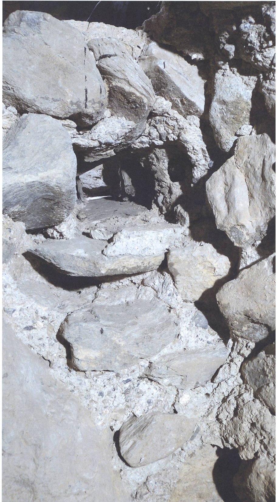
Abb. 81: Tomils, Sogn Murezi. Blick in den Ausgusskanal (1021) in der Kirchenwestmauer (78) nach der Entfernung der Zumauerung. Blick nach Südosten.
