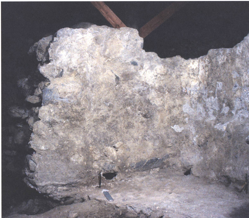
Abb. 77: Tomils, Sogn Murezi. Nordmauer (850) des nördli- chen Seitenraums. Blick nach Nordosten.
