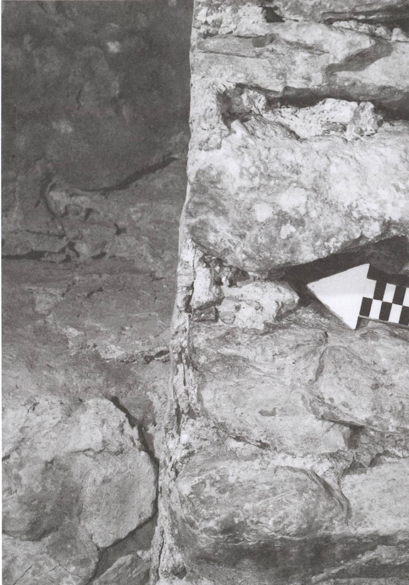
Abb. 113: Tomils, Sogn Murezi. Der Nordpfeil liegt auf einer der Arbeitsfugen im Mauerwerk der südlichen Binnenmauer des Altarraumes (976). Blick nach Osten.
