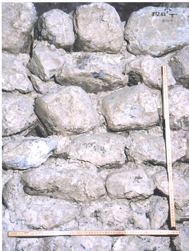
Abb. 144: Tomils, Sogn Murezi. Südannex E. Mauerwerk der Ostmauer (1029). Blick nach Osten.
