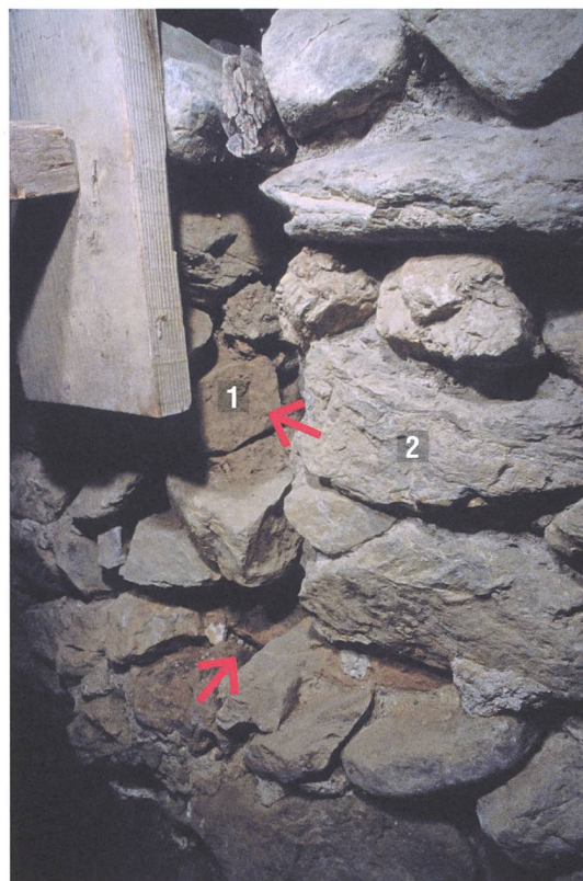
Abb. 173: Tomils, Sogn Murezi. Westannex, Raum F. Die Westmauer (536) mit 1 der Öffnung (1096). Gut zu erkennen ist das nördliche Gewände (Pfeile). 2 Zumauerung (1095). Blick nach Nordosten.
