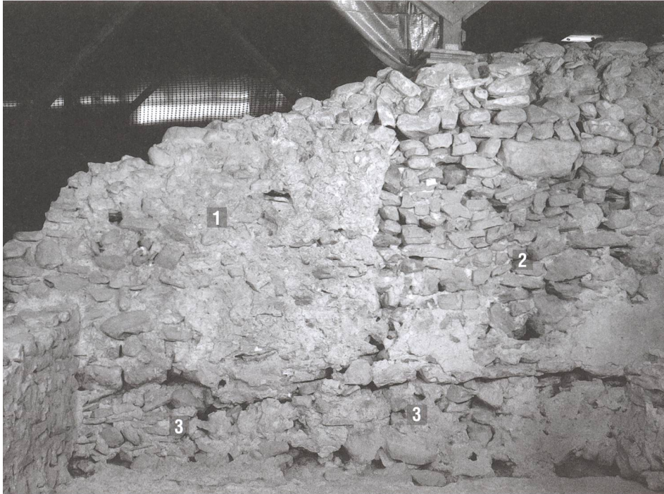
Abb. 196: Tomils, Sogn Murezi. Dreiapsidensaal. Blick an die Kirchensüdfassade. 1 Mauerwerk (964) des südlichen Apsschenkels bindet in 2 die Südmauer (979) der ersten Kirche ein. Im unteren Bereich ist 3 der Standort der einstigen Sitzbank (1046) abzulesen. Blick nach Norden.
