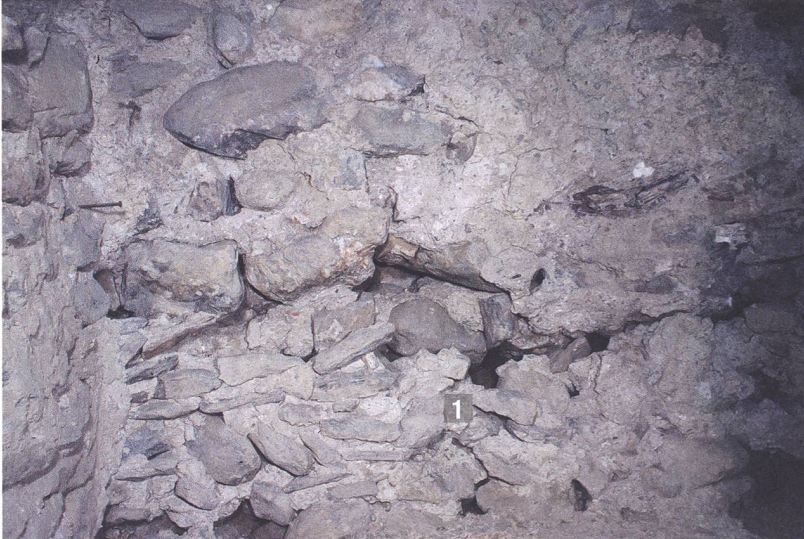
Abb. 206: Tomils, Sogn Murezi. Südannex E. Der einstige Standort der 1 Sitzbank (1046) ist an der Nordwand abzulesen. Blick nach Norden.
