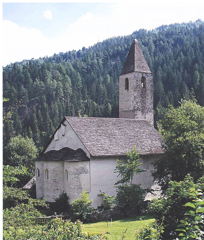
Abb. 220: Alvaschein, Mistail. Die ehemalige Klosterkirche St. Peter aus karolingerzeitlicher Zeit. Der Turm und das steile Dach sind jünger. Blick nach Südwesten.
