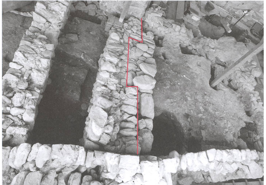
Abb. 223: Tomils, Sogn Murezi. Westannex, Raum F. Binnenmauer (534) mit Nische. Ihr wurde in der Zeit um 800 eine zweite Mauer (535) vorgeblendet und die Nische (rot) mit deren Mauerwerk verschlossen. Blick nach Osten.
