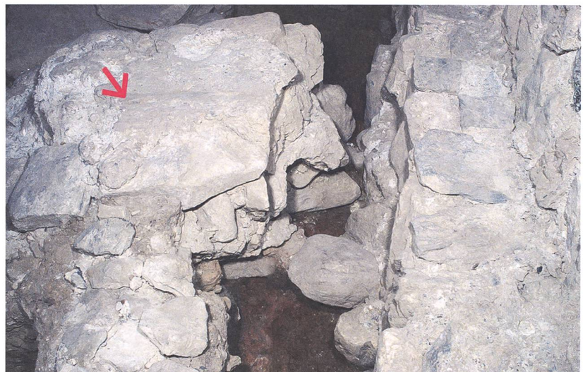
Abb. 235: Tomils, Sogn Murezi. Südannex E, Westerweiterung. Negativ des Schwellenbretts (Pfeil) im Mauermörtel der Westmauer (336). Blick nach Westen.
