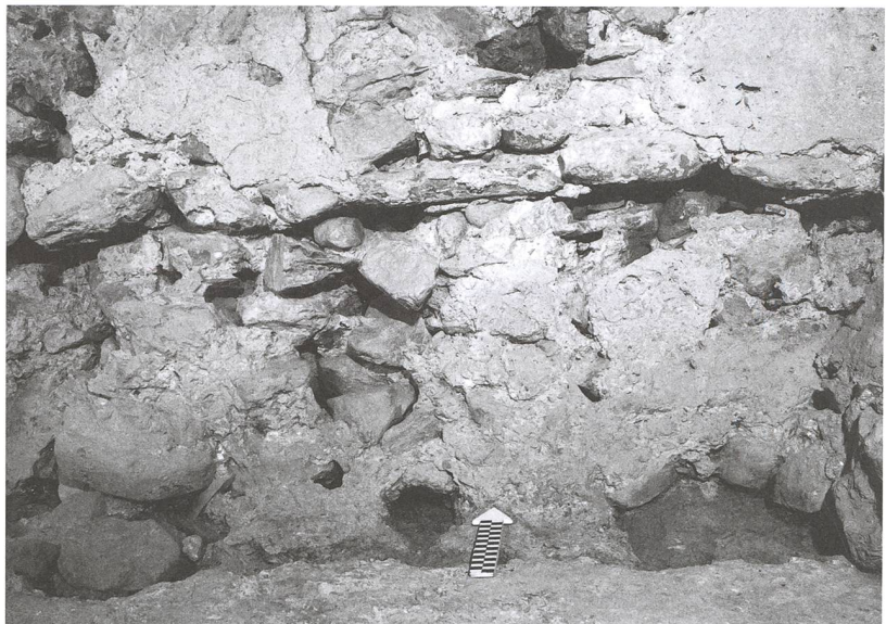
Abb. 245: Tomils, Sogn Murezi. Südannex E. Detail des Flickmauerwerks (1052) am einstigen Standort der Sitzbank entlang der Nordwand. Blick nach Norden.
