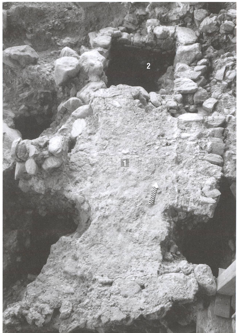
Abb. 274: Tomils, Sogn Murezi. Westannex. Der gangartige Raum K besass einen 1 Mörtelboden (789) und einen 2 Schacht am Nordende. Blick nach Norden.
