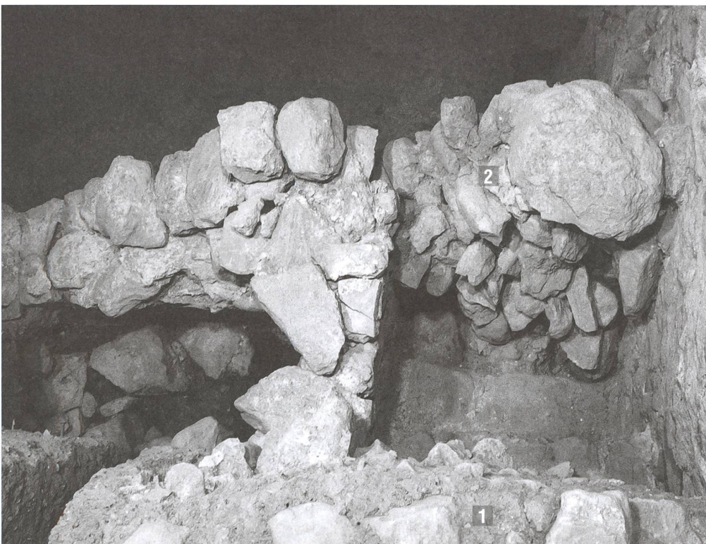
Abb. 319: Tomils, Sogn Murezi. Südannex, Osterweiterung. 1 Die Treppe wurde mit Abbruchschutt (1059) verfüllt, 2 Zumauerung (1049) des Durchganges (1044) ins obere Geschoss. Blick nach Westen.
