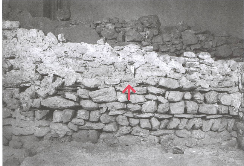
Abb. 321: Tomils, Sogn Murezi. Südannex E. Erneuerung (1026) der Südmauer (Pfeil). Blick nach Süden.
