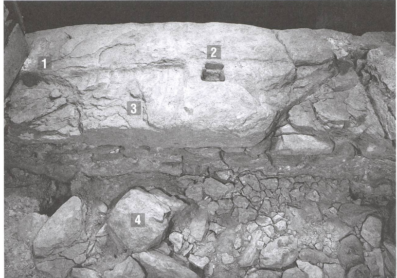
Abb. 404: Tomils, Sogn Murezi. Zwischen 1 der Vertiefung für die Drehangel des westlichen Türflügels und 2 der Vertiefung für den Türanschlag sind in der Steinplatte die 3 Furchen der aufliegenden Türflügel des Kirchenportals zu erkennen. 4 Reste der Stufe. Blick nach Süden.
