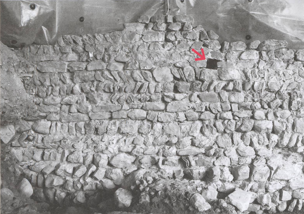
Abb. 401: Tomils, Sogn Murezi. Blick an die Fassade und das Fundament der Kirchennord- mauer (26) mit dem Gerüstloch (891a, Pfeil).
