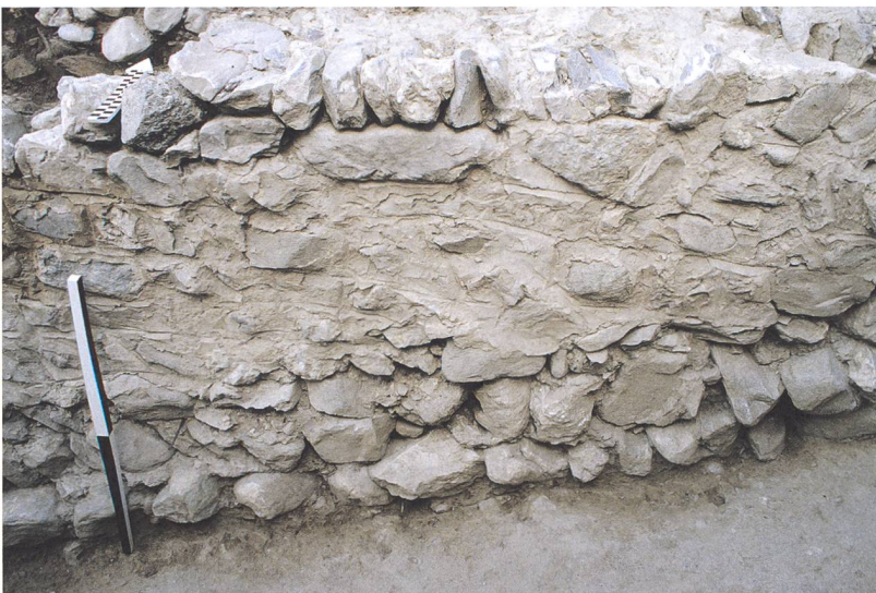
Abb. 413: Tomils, Sogn Murezi. Rasa-Pietra -Verputz und Fugenstrich an der Friedhofsmauer (50). Blick nach Norden.
