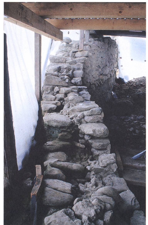
Abb. 412: Tomils, Sogn Murezi. Wie die Abbruchkronen zeigt, wurde die Friedhofsmauer (50) als Schalenmauerwerk errichtet. Blick nach Osten.
