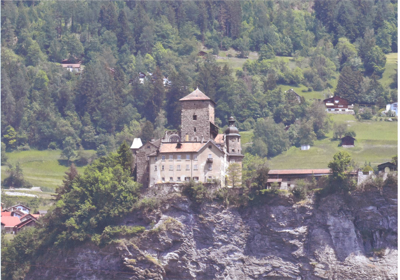
Abb. 4: Tomils, Schloss Ortenstein. Der zentrale Turm der mittelalterlichen Burg wurde 1280 erbaut. Blick nach Osten.
