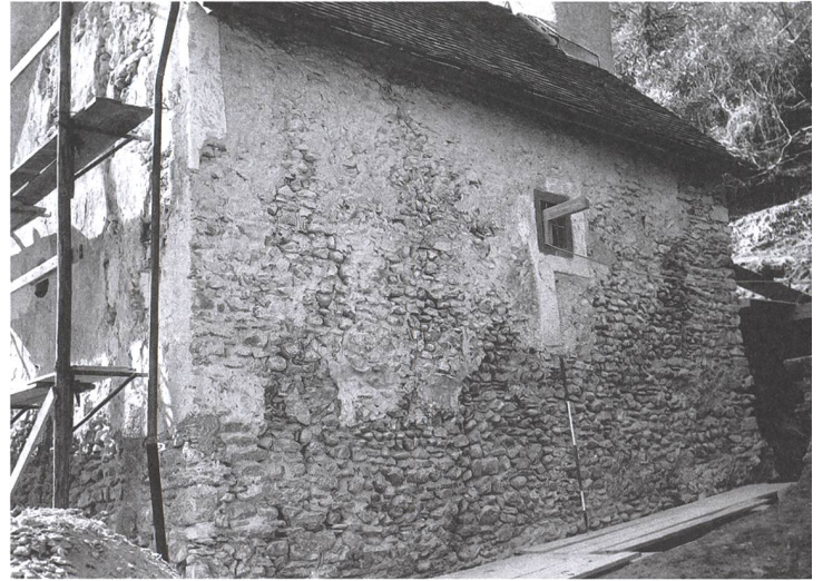
Abb. 15: Domat/Ems, Sogn Pieder. Nordfassade während der Freilegung des Mauerwerkes. Blick nach Süden.
