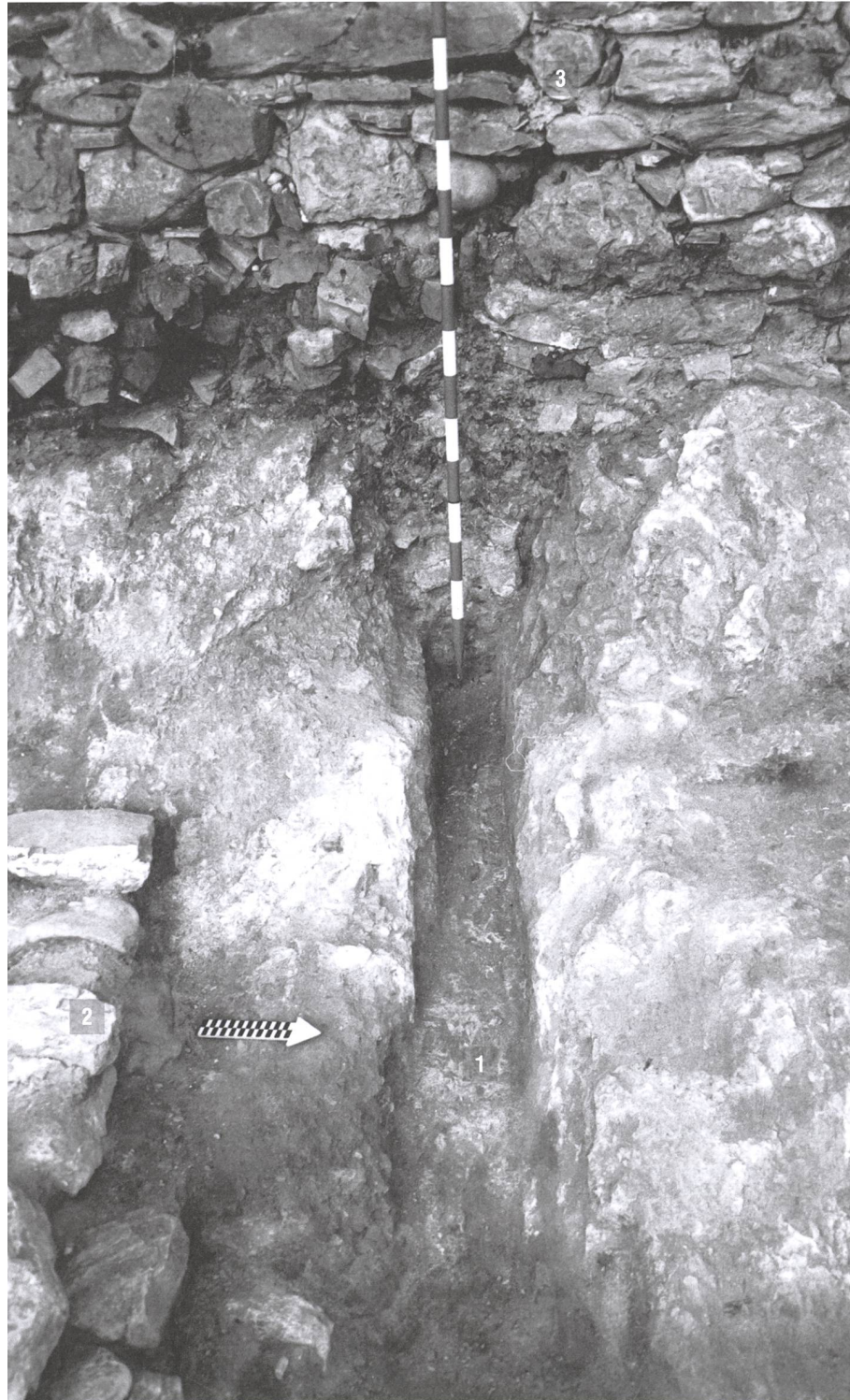
Abb. 56: Domat/Ems, Sogn Pieder. Anlage 1. Die 1 Rinne (451) diente der Entwässerung des Hanges an der Nordseite des Gebäudes. 2 Nordmauer (28) von Raum F. 3 neuzeitliche Hangstützmauer. Blick nach Westen.
