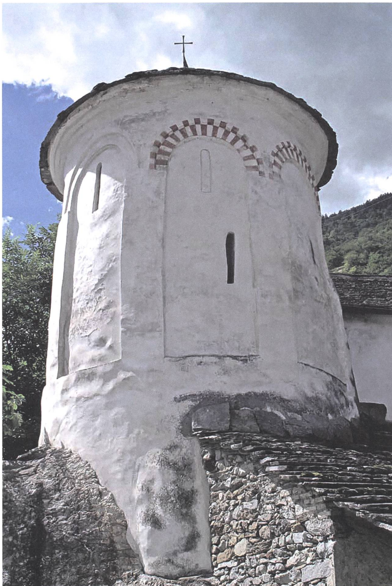
Abb. 117: San Vittore, Kapelle S. Lucio. Die Lisenen des karolingerzeitlichen Rundbaus stehen auf einem hohen Sockelband; die einmal getreppten Bogen über den Blendfeldern weisen ein Backsteinmuster auf.
