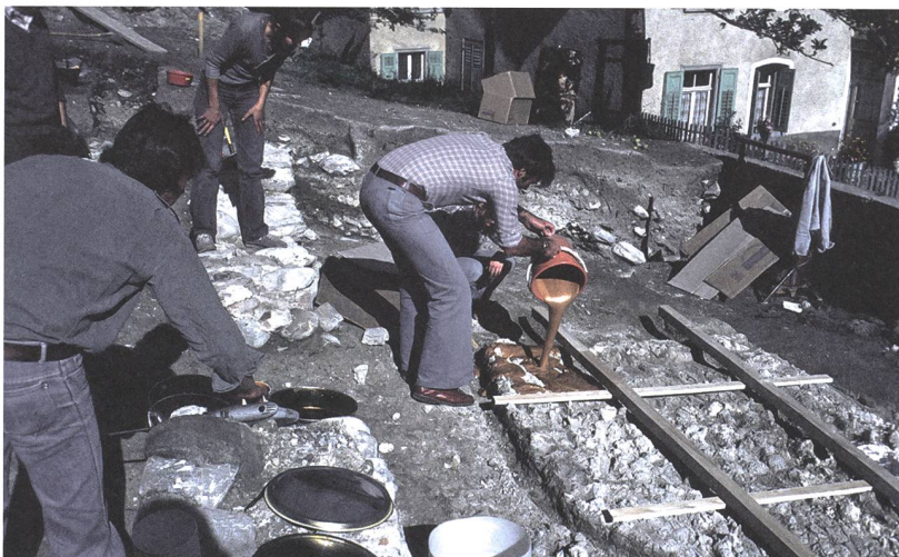
Abb. 33: Domat / Ems, Sogn Pieder. Anlage 1. Ostmauer. Der gefestigte und mit Holzbalken armierte Verputz (Innenseite) der Fassade wird mit Polyurethanschaum zu einem kompakten Schichtenpaket verklebt und anschliessend en bloc vom Untergrund gelöst. Blick nach Norden.
