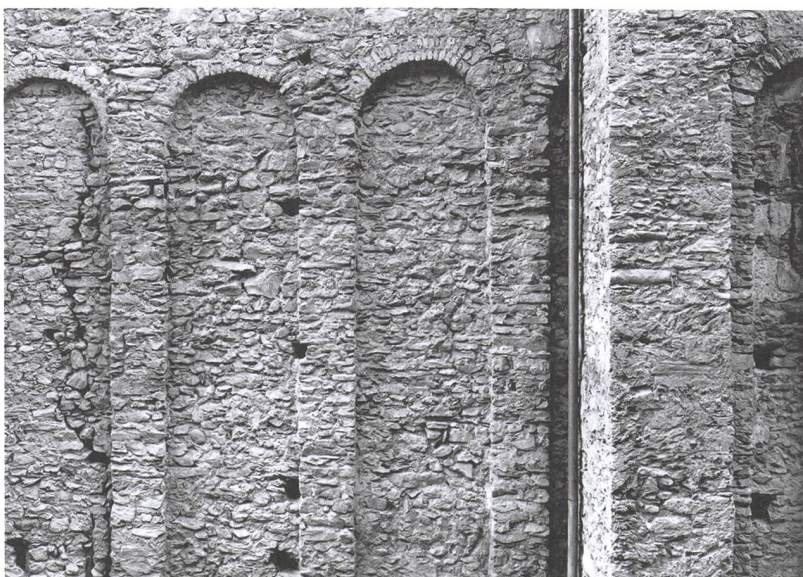
Abb. 113: Chur, Kirche St. Martin. Blendarkaden an der karolingerzeitlichen Südfassade.
