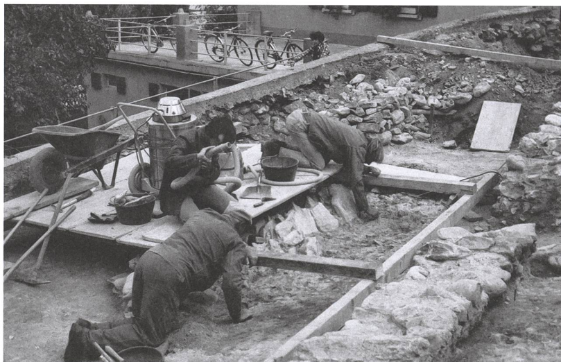
Abb. 32: Domat / Ems, Sogn Pieder. Anlage 1. Vorsichtig werden die Mauersteine der umgekippten Ostmauer abgebaut und die darunter liegende Innenseite der Verputzschicht für die Festigung mit Kieselsäureester vorbereitet. Blick nach Südosten.
