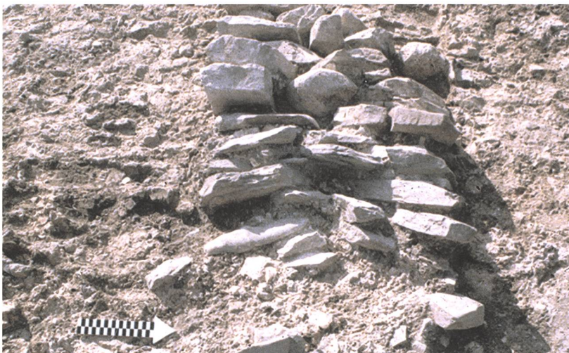
Abb. 30: Domat/Ems, Sogn Pieder. Anlage 1. Mauerwerk einer Lisene der umgekippten Ostmauer. Deutlich sichtbar die sorgfältige Schichtung der Bruchsteine. Blick nach Westen.
