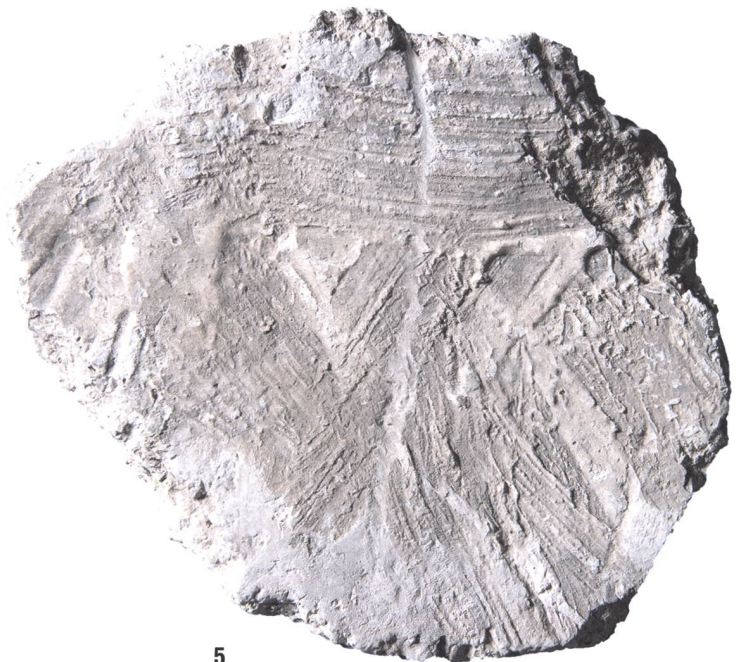
5 Verputz mit Farbauftrag. Auf einer grauen Grundfarbe wurde mit breitem Pinsel eine weisse Kalkschlämme kreuz und quer aufgetragen. Das Weiss füllt einen bestehenden Riss. – Malputz 4 mm.
