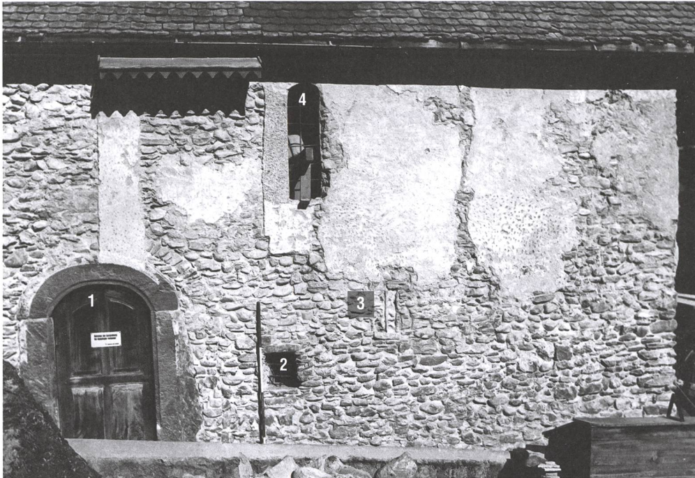
Abb. 134: Domat/Ems, Sogn Pieder. Anlage 2a. Kirche. Das Mauerwerk der Südmauer stammt hauptsächlich aus karolingischer Zeit. Zu den jüngeren Einbauten zählen der 1 Eingang, das 2 Andachtsfenster und das 3 zugemauerte Scharfenfenster. Das 4 Rundbogenfenster stammt aus karolingischer Zeit, der obere Abschluss wurde während späteren Umbauten verändert (vgl. Abb. 129 ). Blick nach Norden.
