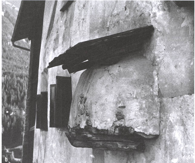
Abb. 167: a Bregaglia, Stampa, Coltura. Apsisförmiger Backofen am Wohnhaus. b Scuol. Der Backofen ist an der Aussenseite der Küche angebaut, er wird durch Konsolbalken gestützt.
