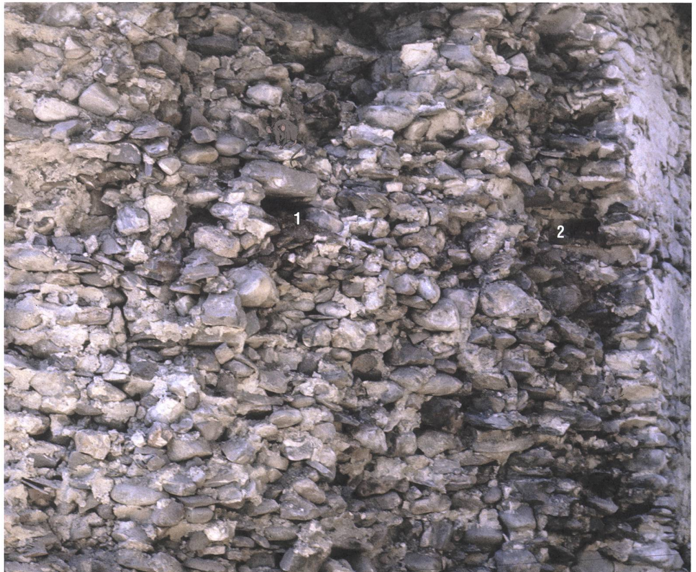
Abb. 137: Domat/Ems, Sogn Pieder. Anlage 2a. Kirche. Blick in den Mauerker des Chores. 1 Negativ des Armierungsbalkens (647). 2 Negativ des Armierungsbalkens (648). Blick nach Südwesten.
