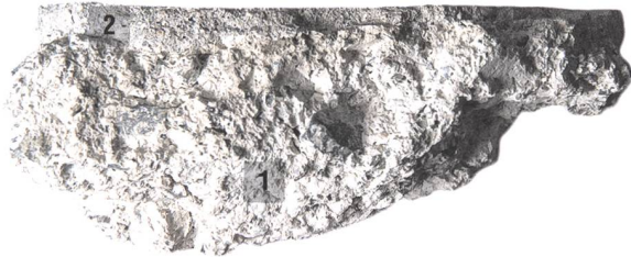
Abb. 152: Domat/Ems, Sogn Pieder. Anlage 2a. Kirche. Aufbau des Wandverputzes der Gruppe 1: 1 Grundputz mit dünner Kalktünche, darauf der 2 3 mm starke Feinputz mit roter Malerei (vgl. Abb. 151.1 ).
