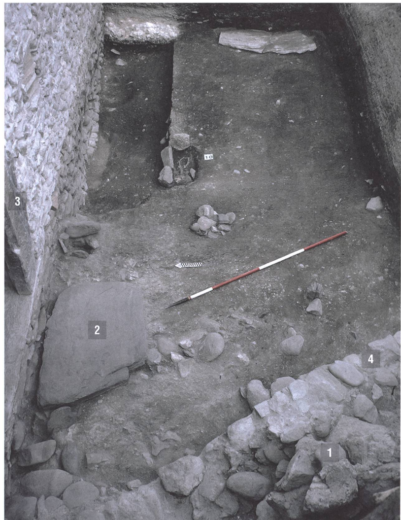
Abb. 184: Domat/Ems, Sogn Pieder. Anlage 2b. Friedhof. 1 neu errichtete Friedhofmauer (8); 2 Steinplatte (92) als Antritt zum Eingang; 3 Kirchenportal (637) der Anlage 4; 4 moderne Hangstützmauer (750). Blick nach Osten.
