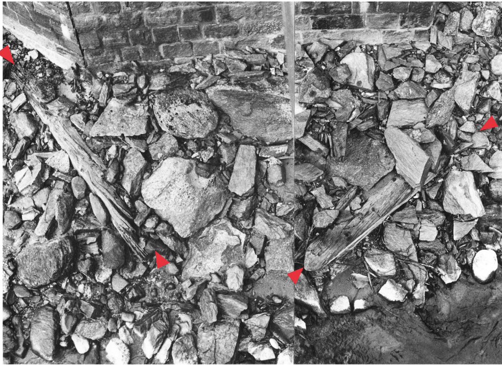
Abb. 51: Scuol. Guarda, un- terhalb Giarsun (Stelle 7.9.3). Reste (Balken, Steinschüt- tung) des linksseitigen Pfei- lers der spätmittelalterlich- neuezeitlichen, hölzernen Innbrücke. Blick von oben.
