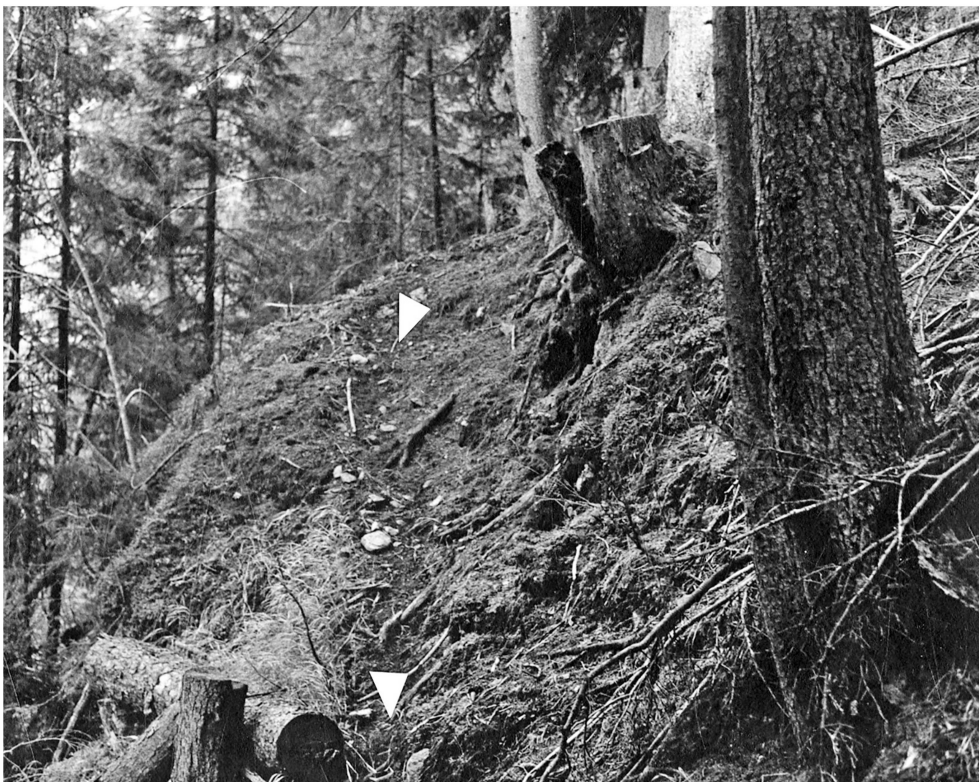
Abb. 43: Scuol, Guarda (Stelle 7.5.1). Rechtsufriger, weitgehend zerstörter Abstieg auf dem Weg zu der von Campell erwähnten, ehemaligen Innbrücke östlich von Giar sun. Dieser ist heute weitgehend zerstört. Blick nach Osten.
