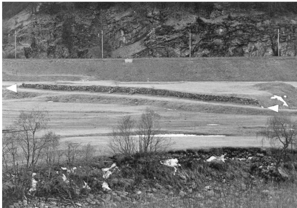
Abb. 67: Zernez. Susch, Cuschinai (Stelle 8.8.2). Der neuzeitliche Fahrweg wurde oft so in die Landschaft gelegt, dass er möglichst wenig Kulturland zerstörte, hier in der Böschung einer ehemaligen Inn-Terrasse. M gut erhaltene Mauer mit Trasse des Fahrweges 1776 (Fortsetzung des Abschnittes Stelle 8.8.1, Abb. 66 ). Blick nach Nordwesten.
