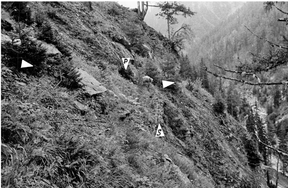
Abb. 99: Val Müstair. Sta. Maria (Stelle 12.5). Südlich von Plattatschas, unterhalb der heutigen Strasse. Blick in den abschüssigen Hang mit Wegkorrektur des angehenden 18. Jahrhunderts. Der Weg musste talwärts durch zahlreiche Stützmauern gesichert und bergwärts an vielen Stellen «geschnitten» werden. Heute ist der Hang stark zugewachsen. S Stützmauer Stelle 12.5.1 , Abb. 100 . P Profil Stelle 12.5.2 , Abb. 101 . Blick nach Südsüdosten.
