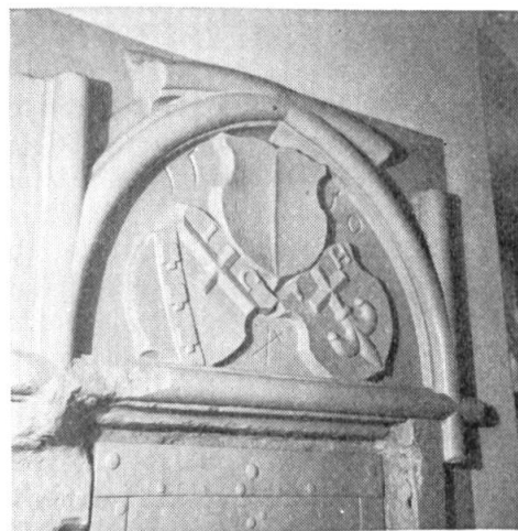
Fig. 5. Armoiries à l'ancienne commanderie de Reiden (Lucerne).
