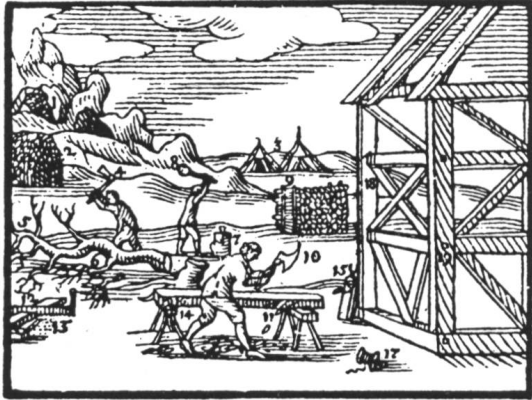
Fig. 41 Les différentes étapes du travail du charpentier, de l'abattage des arbres à l'édification d'une charpente et de l'ossature d'une maison à colombages. Gravure extraite de J. A. Comenius, ORBIS SENSUALIUM PICTUS , Nuremberg 1658.
