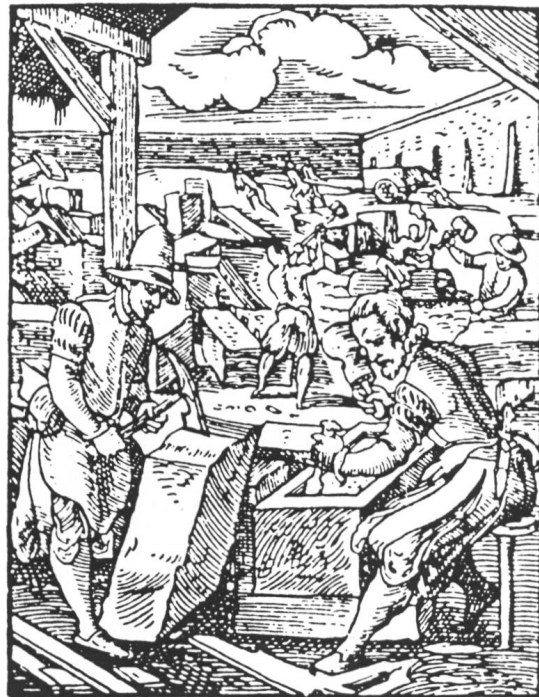
Fig. 34 Tailleurs de pierre, gravure de Jost Amman, parue en 1568. L'artisan de gauche se sert du pic pour tailler la pierre et celui de droite d'un ciseau et d'un maillet en bois déjà usé. Il est aussi sur un tabouret à un pied. On distingue au premier plan une partie d'un niveau de maçon à fil à plomb.
