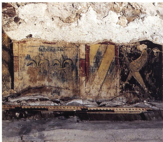
Rheingasse 43, Basel, Antoniterhof Fragmente der Malerei aus dem Saal im 1. OG, 2. Hälfte 15. Jahrhundert; Stück von Ostwand, mit den Wappen der Herzöge von Burgund. Basler Denkmalpflege, Foto Erik Schmidt, November 1999.
