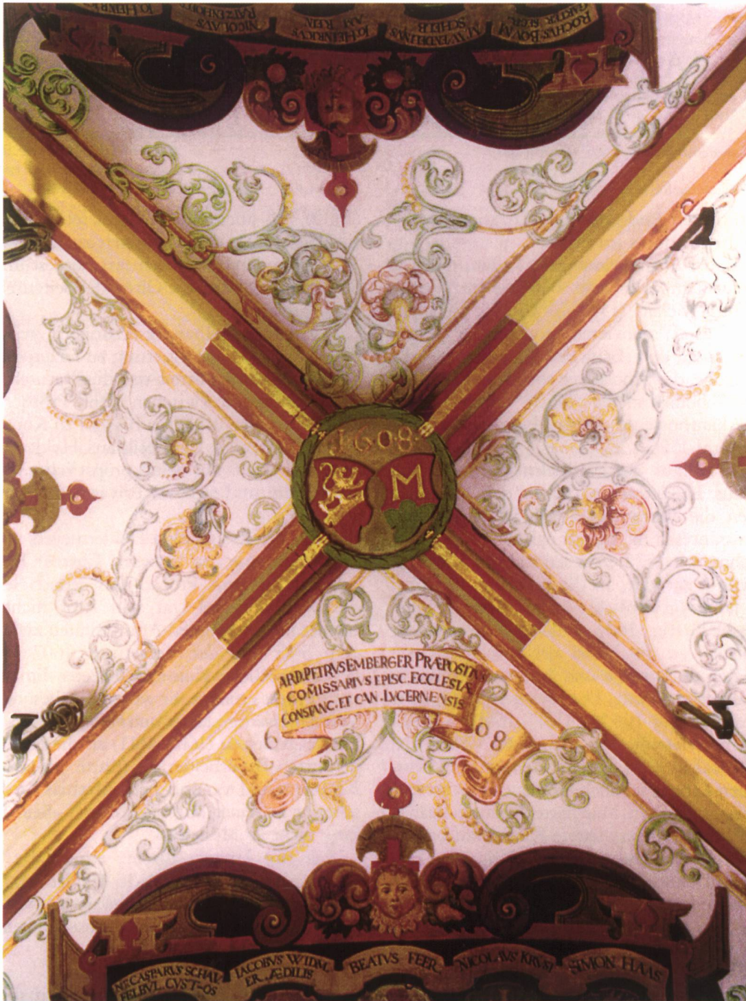
Abb. 1: Das Kreuzrippengewölbe des Archivs Sigolter oder Sigeltal im Erdgeschoss des Turms, samt dem Schlussstein mit den Wappen von Stift St. Michael und Probst Peter Emberger mit Jahreszahl 1608.
