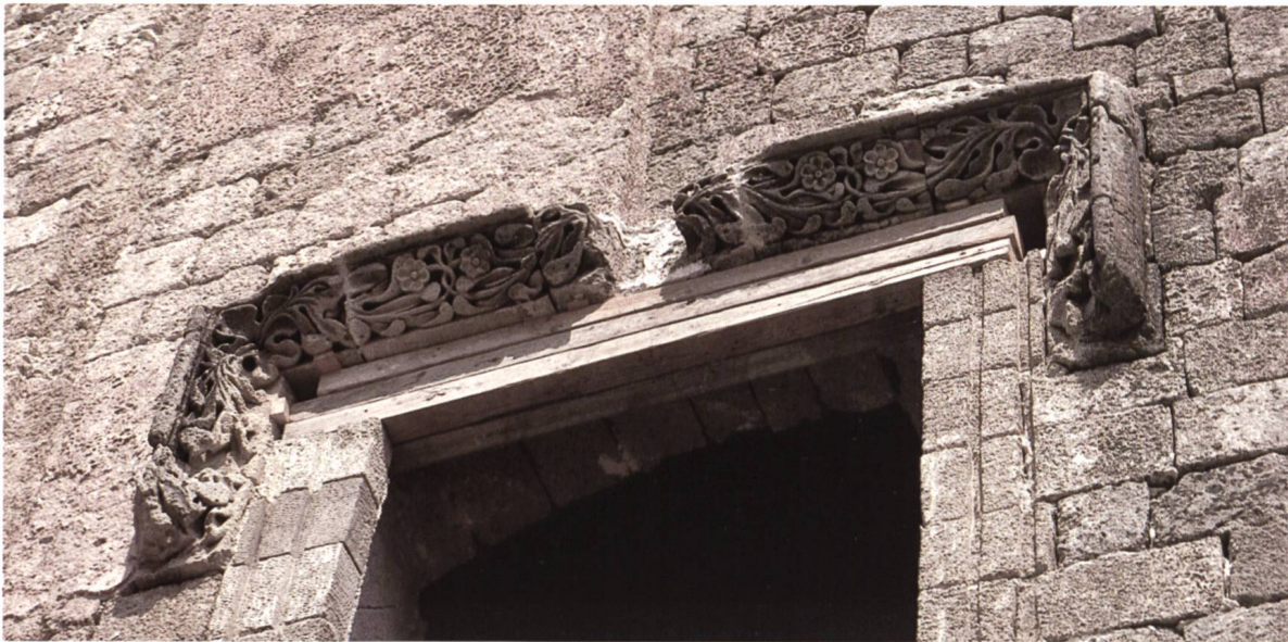
Fig. 5 Détail d'une fenêtre de la maison de Guillaume Caoursin (cl. JBV)
