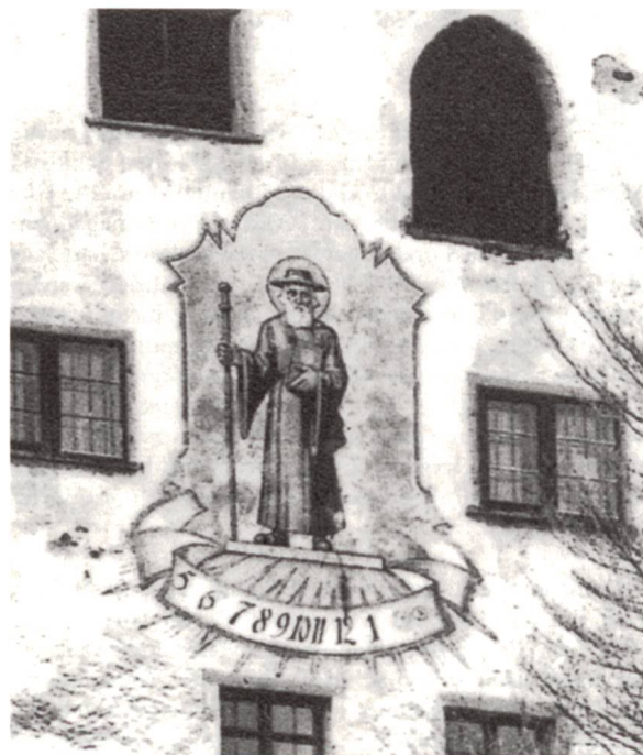
Ill. 4: Glarner Wappen an der alten Schlossfassade vor der Renovierung 1978 (Broschüre Schloss Werdenberg, o.A., o.J.)
