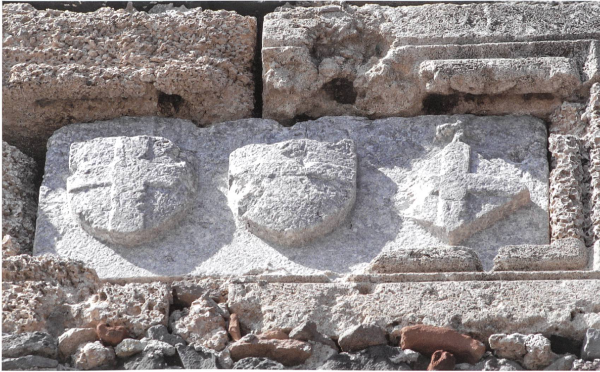
Fig. 20 Caisson sur la face sud-est de la tour de Nissiros (cl.JBV)
