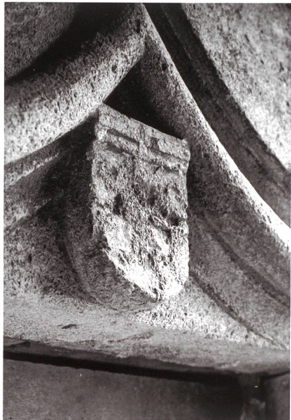
Fig. 15 Écu du linteau en 1982 (cl.JBV)
