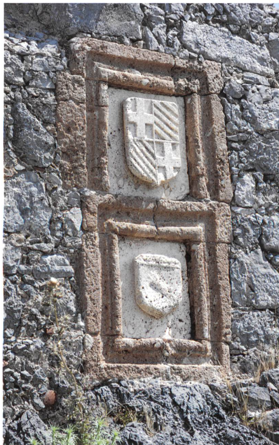
Fig. 11 Chorio. Double caisson du bastion oriental (cl. JBV)
