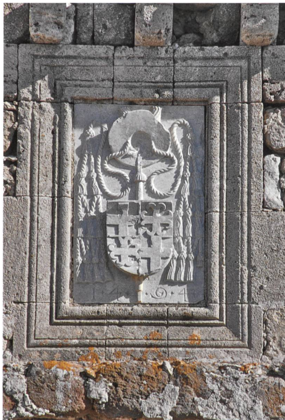
Fig. 16 Andimachia. Caisson aux armes du grand maître Pierre d'Aubusson. 1494 (cl. JBV)
