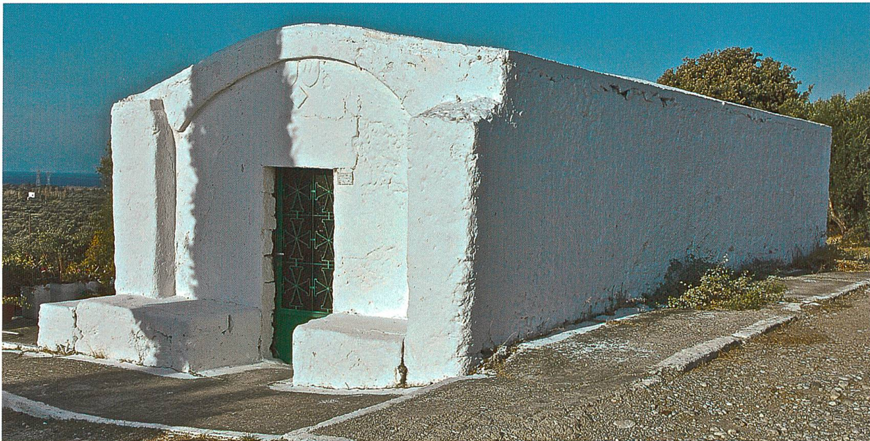
Fig. 1 – Chapelle Saint-Luc-le-Vieux à Soroni (cl. JBV)
