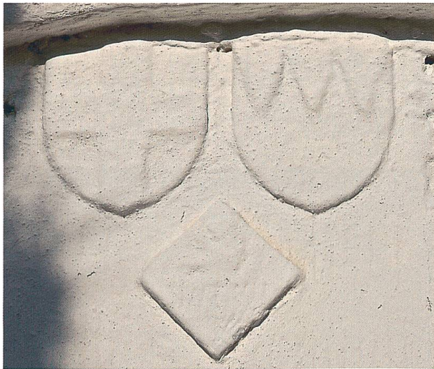
Fig. 2 – Caisson de la chapelle avant restauration (cl. JBV 1994)
