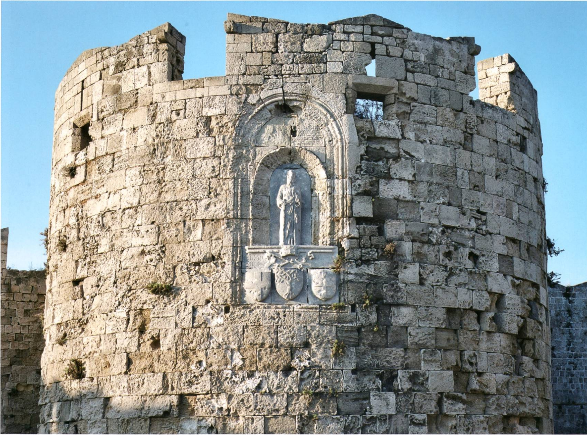
Fig. 15 – Partie supérieure de la tour Saint-Paul (cl. JBV).
