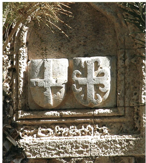
Fig. 14 – Caisson sur l'avant-mur du palais magistral (cl. JBV).
