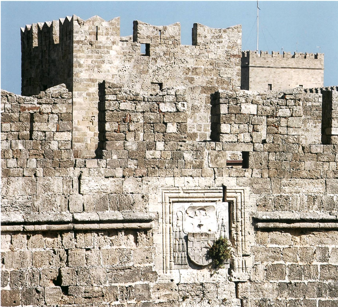
Fig. 21 – Caisson d'Aubusson sur le parement de la face sud du boulevard d'Auvergne (cl. JBV).
