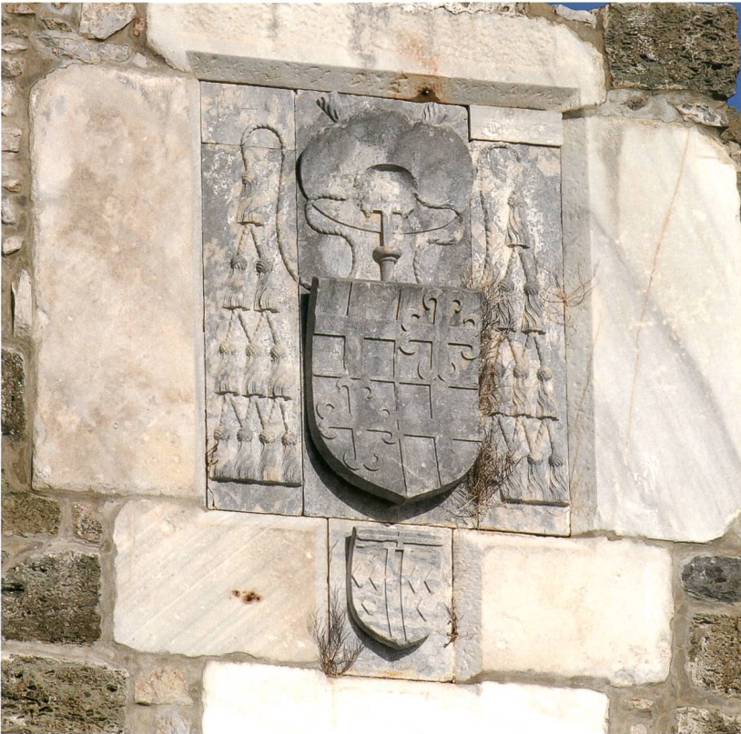
Fig. 25 – Caisson apposé sur la courtine sud du Château Saint-Pierre (cl. JBV).
