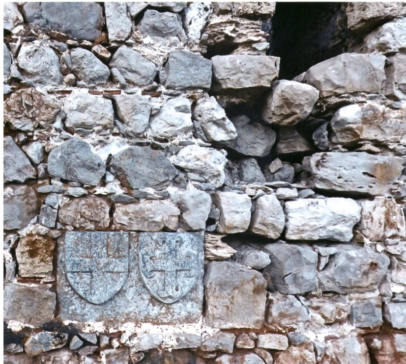
Fig. 2 – Caisson de Pyrgos Palati (cl. JBV).
