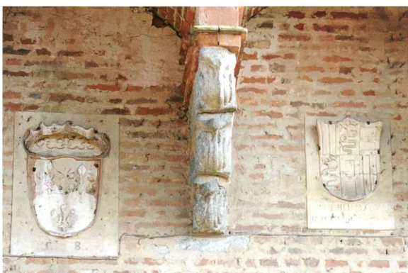
Fig. 13 Stemmi sotto la Balconata, nel prospetto settentrionale, Castello di Mirabello (PV).
