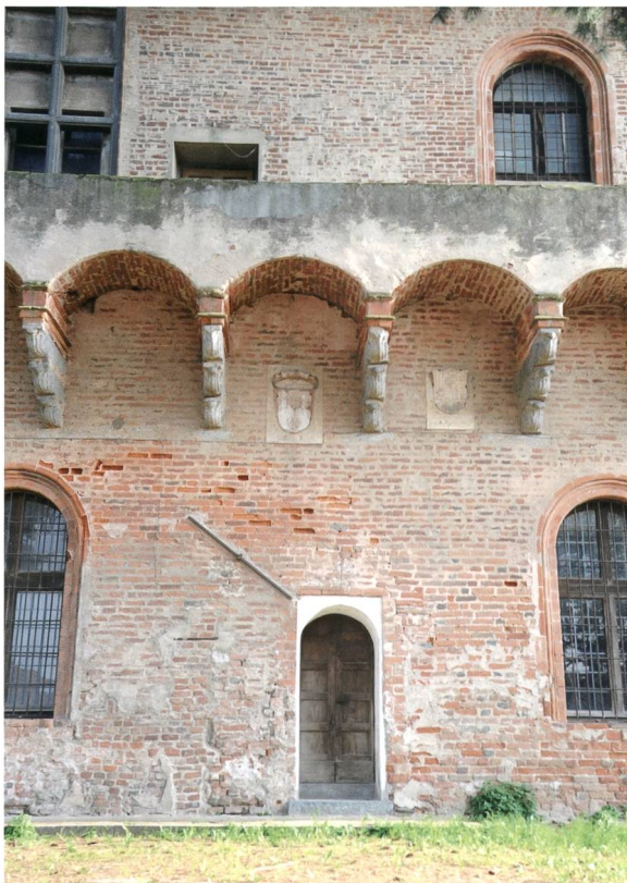
Fig. 12 Balconata nel prospetto settentrionale, Castello di Mirabello (PV).
