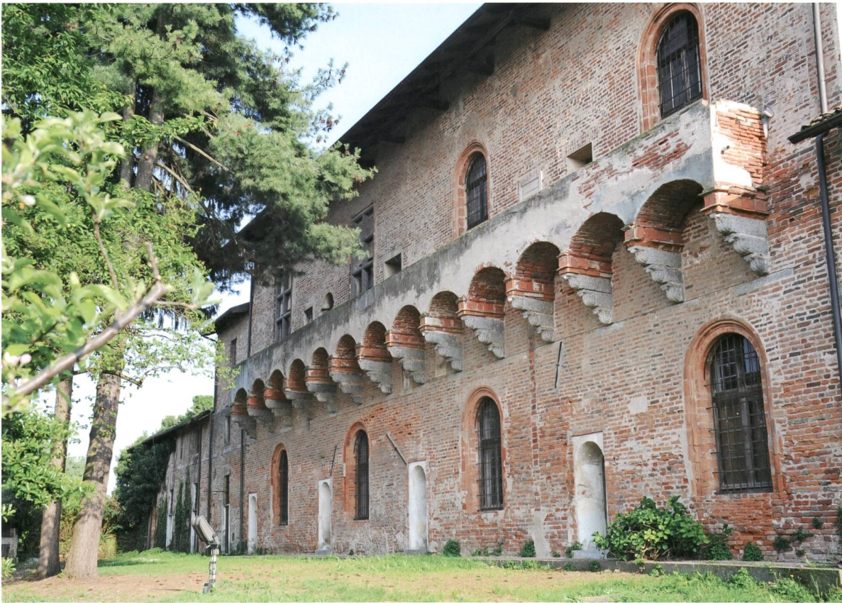
Fig. 11 Castello di Mirabello (PV).
