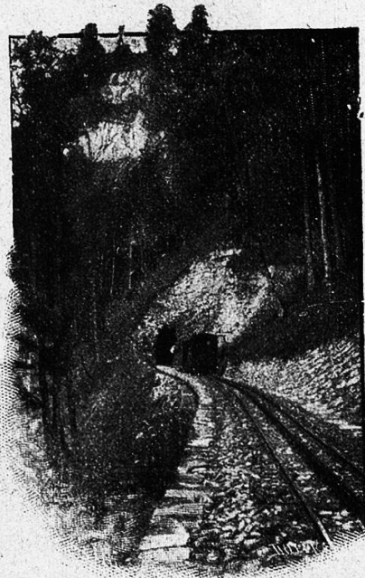
Eingang z. Schwarzfluh-Tunnel.
