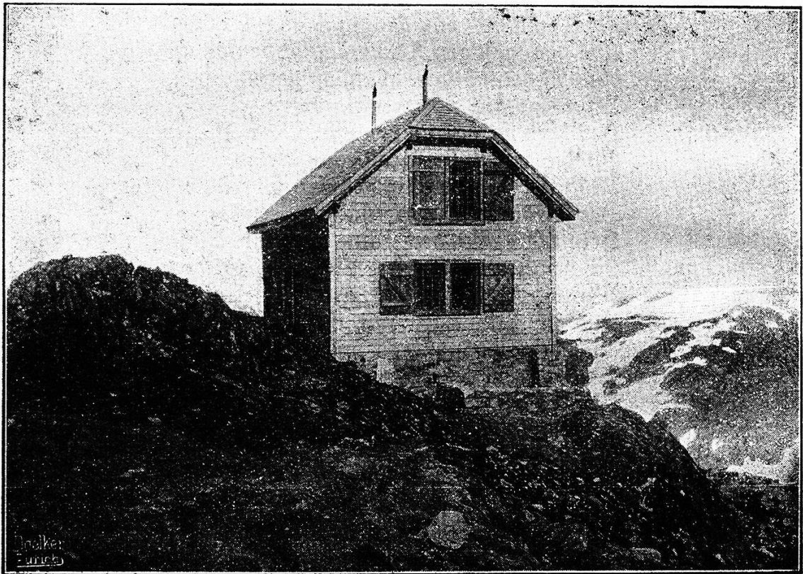
Die neue Rotondohütte im Gotthardgebiet.
