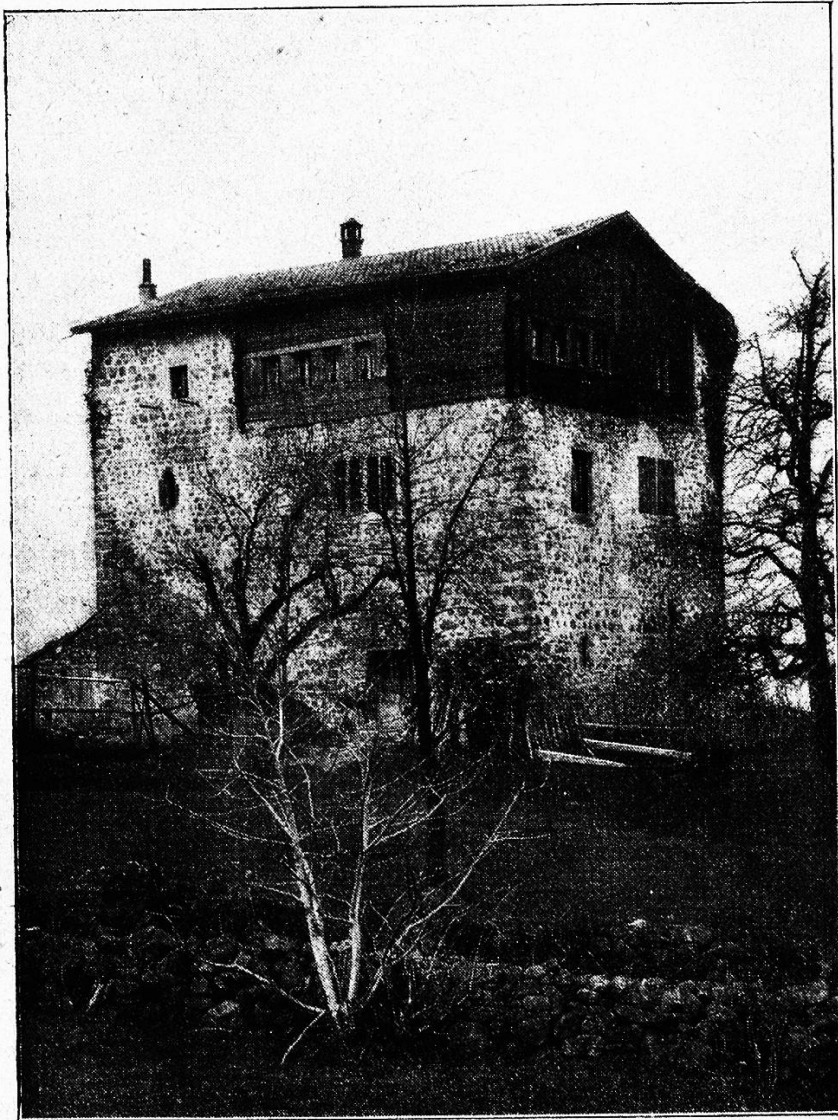
Das Haus von Walther Fürst in Attinghausen (Uri). Auf hoher steinerner Unterlage ruht das tiefbraune Holzwerk.
