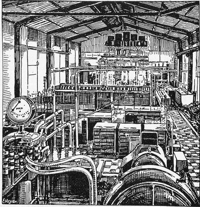
1. Der Senderraum der 1000-KW-Station Radio Argentina.
