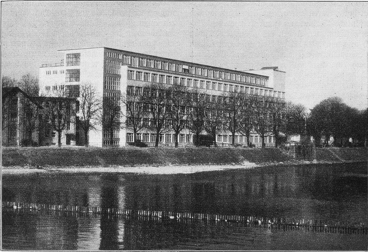
Das neue Gewerbeschulhaus in Zürich.
