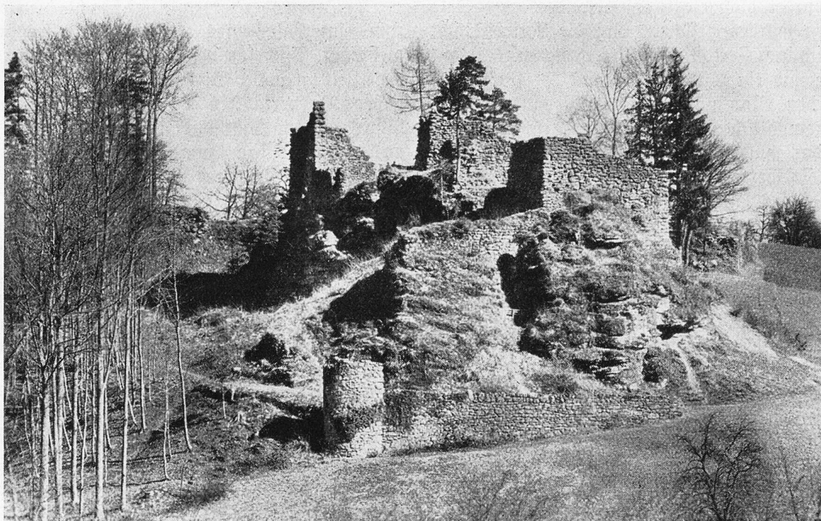
Wädenswil. Burgruine von Norden.
