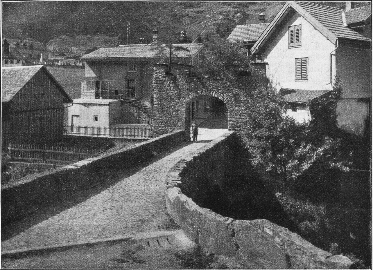
Göschenen. Die alte Zollbrücke.
