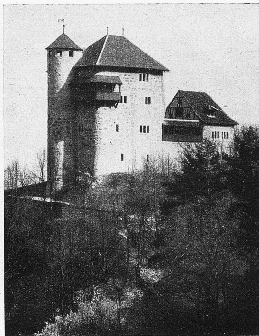
Burg Rotberg nach dem Ausbau
