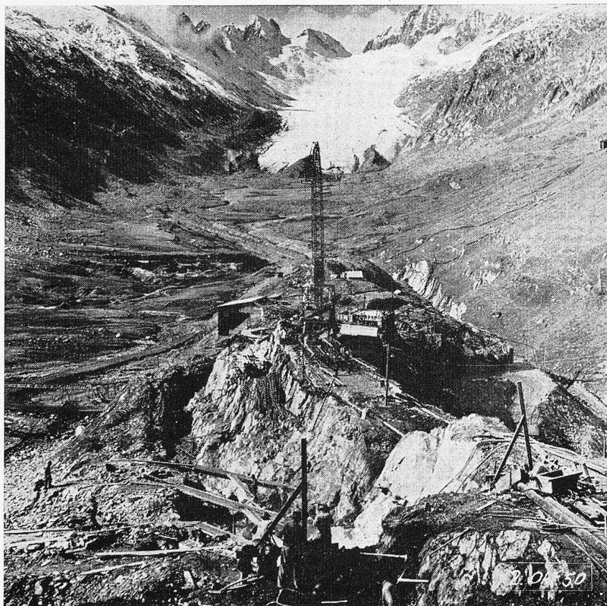
Oberaarloch mit Oberaargletscher, im Vordergrund der Fundamentaushub für die Staumauer Oberaar
