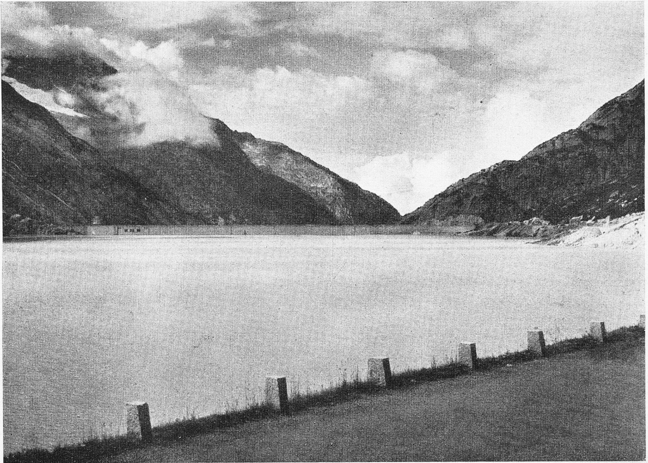
Staumauer Räterichsboden, Kraftwerk Handeck II, Wasserseite
