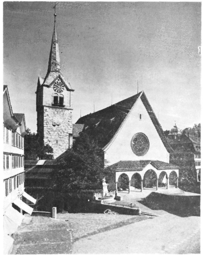
Herisau, die Kirche von N.-W. nach der Renovation von 1906 mit Vorzeichen, Türen und Fensterrose in neugotischem Stil.
