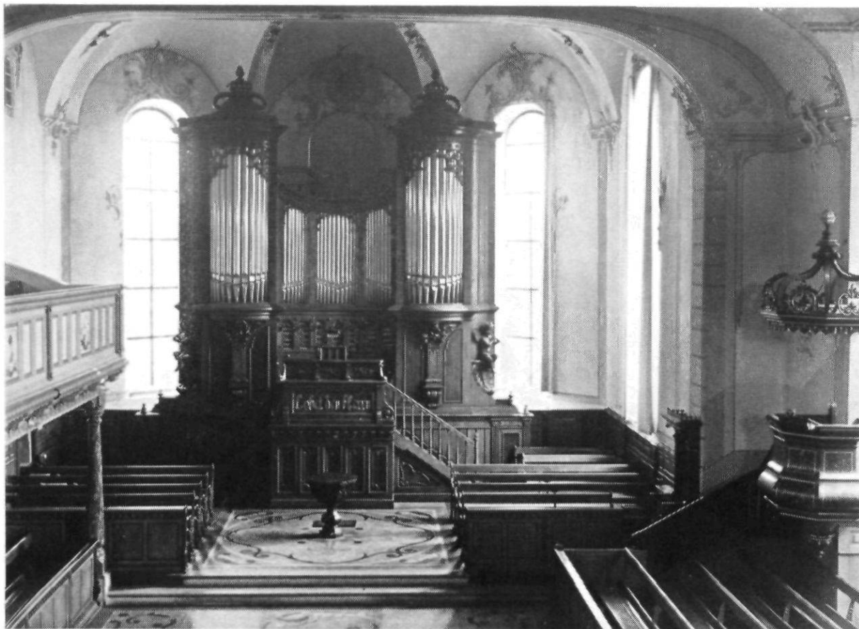
Teufel, das Chor im Zustand vor der Restaurierung von 1959/60 mit der Orgel im Neurokoko-Stil und dem mosaikartig verlegten Steinzeughboden von 1893/94.
